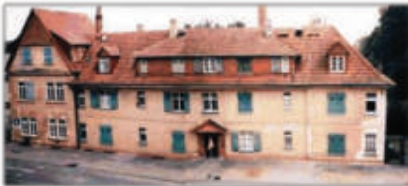
Das 1882 errichtete Haus am Borkenberg kurz vor dem Abriss 1985
