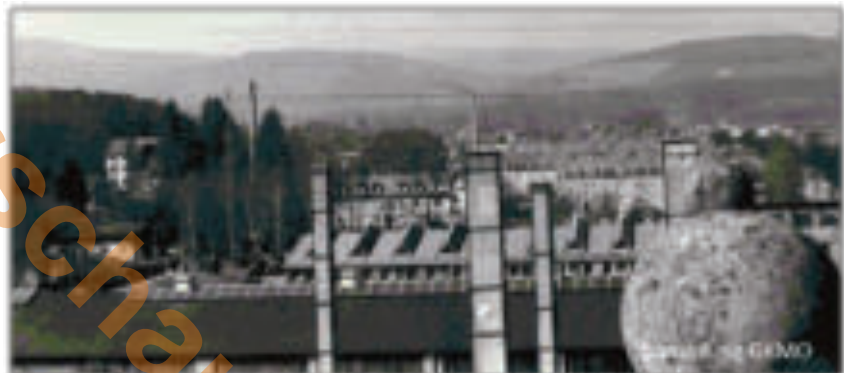
1953 - Die Fabrikschornsteine im Industriegebiet am Urselbach
