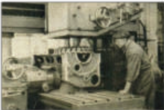
Bearbeitung Kurbelgehäuse der A/F6M Motoren im Werk Deutz 1935
