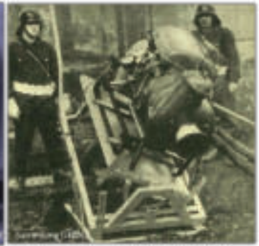
Die T16 in der Kältekammer bei -40°C und beim Funktionsnachweis für Betrieb in Schräglagen
