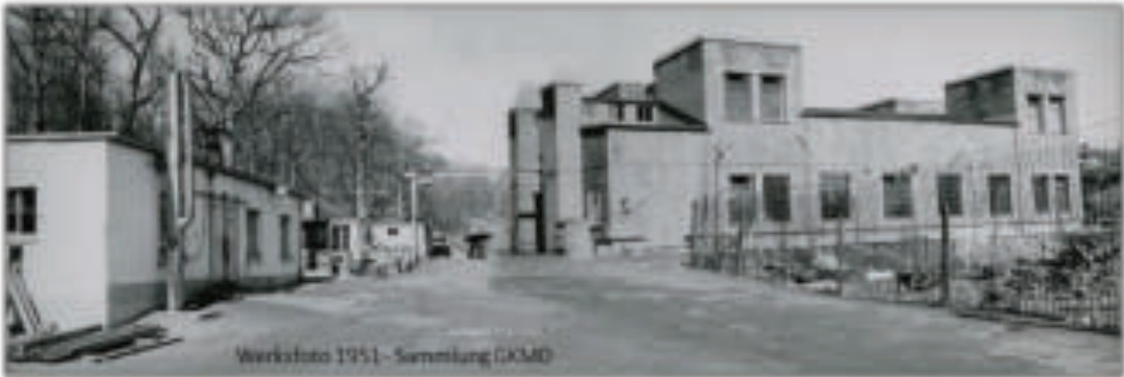
Das KHD-Werk mit dem umgebauten Turmbau und neu errichteten Nebengebäuden vom Werkstor her gesehen
