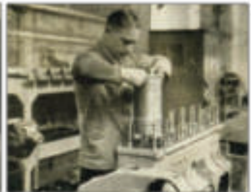
Einsetzen der Zylinderlaufbüchsen
