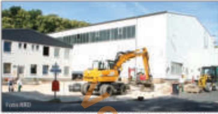
2009 – Vorbereitungen zu einem optimierten Logistikbereich, mit neuem Lagersystem und Verlegung des Versand in Halle 36
