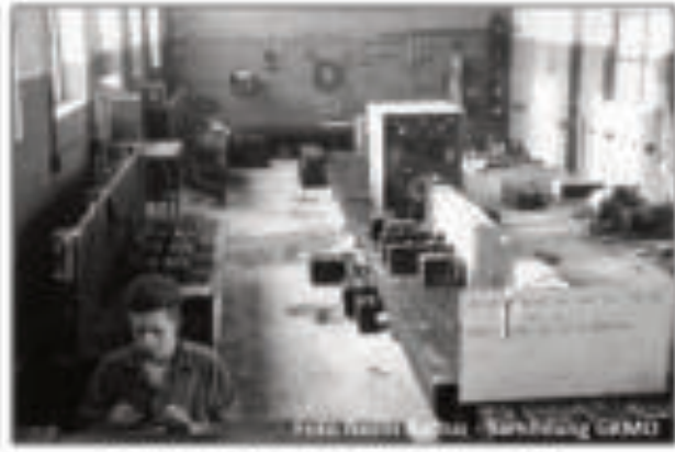
Batterie-Laderraum im Werkgebäude 06
