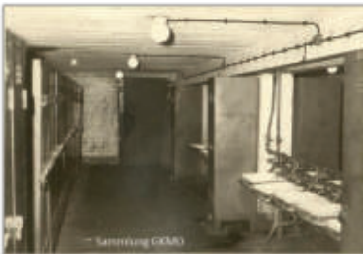
Umkleide- und Waschräume im Keller des Turmbau
