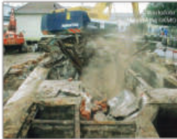
1997 - Abriss der Schlammfanganlage im Zulauf zum Pumpenhaus, im Hintergrund das Trafohaus
