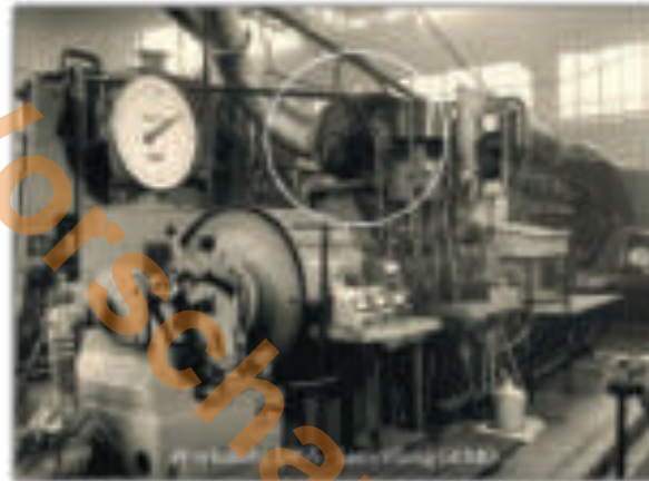
V8-Schiffsdieselmotor mit Abgasturbolader B 28 auf dem Motorenprüfstand im Werk Köln-Deutz 1955
