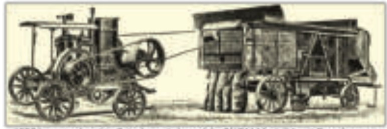
1896 herausgebrachte Petroleum-Lokomobile Gnom Modell A mit Dreschwagen
