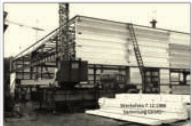
Errichtung der „T53-Montagehalle“ Gebäude 28
