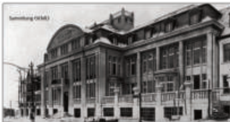
Das neue Verwaltungsgebäude im Winter 1917/1918 - Mittelbau und rechter Seitenflügel fertiggestellt, der linke Seitenflügel noch im Endausbau
