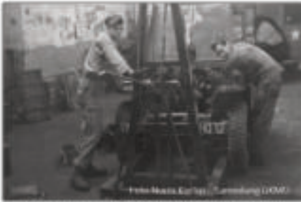
Fahrzeugreparatur – Motorwechsel bei einem Jeep
