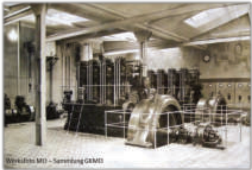
Kraftzentrale im Gebäude 05 um 1929, vorn die zwei 375 PS-Motoren
