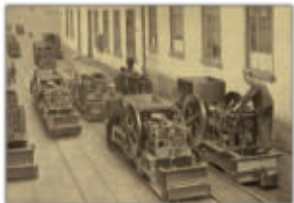
Endmontage- und Prüffeld vor den Werkhallen
