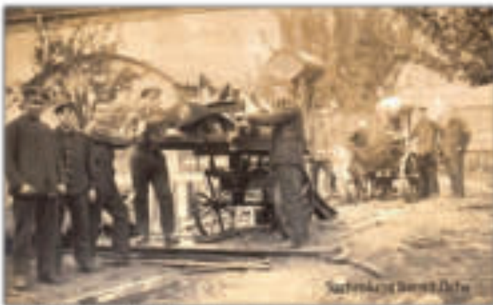
1914 - Erste Motorprüfläufe unterhalb der unterkellerten Flugmotorenhalle
