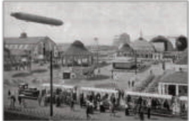
ILA 1909 – Fertigblinde und Besucherbahn mit MO-Motorlok
