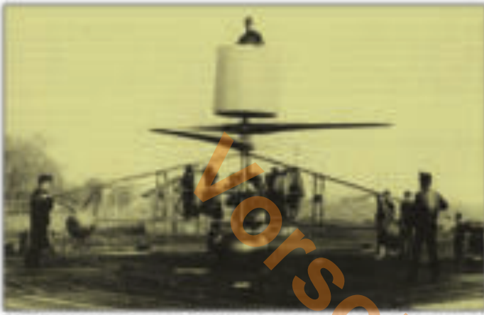
Der Petrocny-Karman-Zurovec Hubschrauber PKZ 2 mit drei Umlaufmotoren und aufgesetzter Beobachter-Plattform
