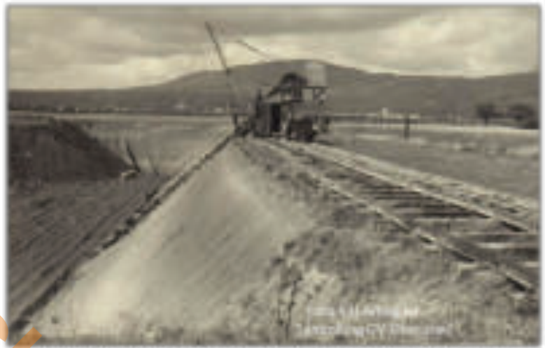
Man entbehren noch die Gruben der Ziegelei an der Homburger Landstraße, in die später der in Oberursel eingesammlte Müll verfüllt wird
