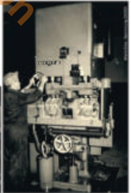
Typische Bearbeitung von Abgasturbolader-Bauteilen
