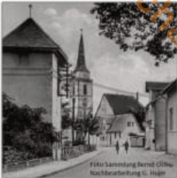
Eine der frühen Umspannstationen in Oberursel.
