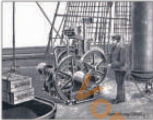
6 PS-Petroleum-Schiffswinde auf der Potosi
