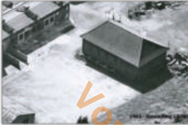
Aufnahme 1961: Das 1941 errichtete Trafohaus; links oben die Kraftstation, der Kohleschuppen links unten
