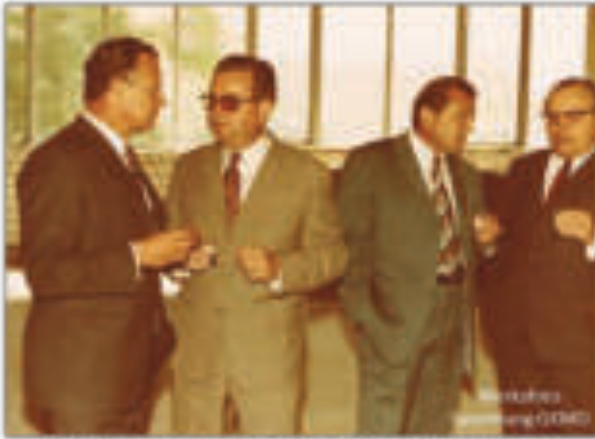
Richtfest zum Ausbildungsgebäude 33 am 1. August 1972, Fertigungsleiter KHD Dr. Wöpkensler, Werkdirektor Ungler, Betriebsratvorsitzender Isenbühl, Entwicklungsdirektor Schnell
