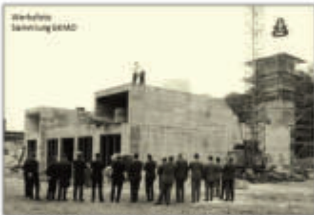
Richtfest für den Prüfstand am 14.10.1966
