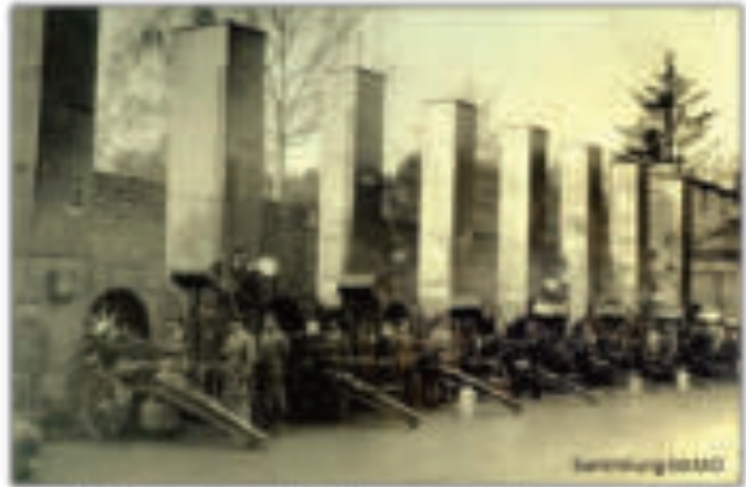
Das 1915 eingerichtete, deutlich vergrößerte Flugmotoren-Prüfelfeld
