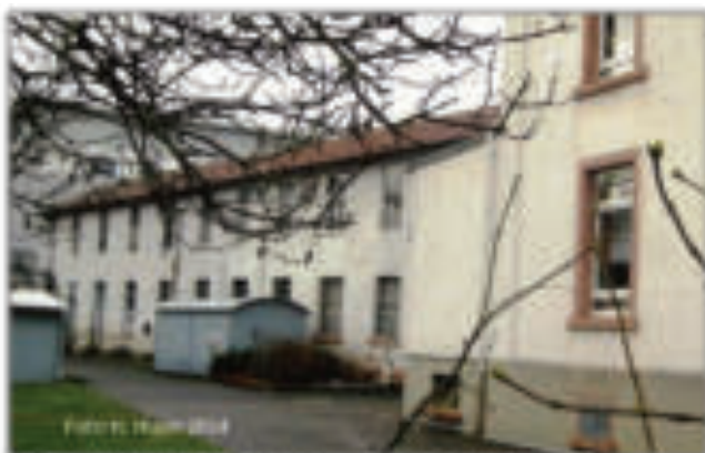
Das Betriebsgebäude der ehemaligen Schreinerei Rempel mit dem mittlerweile verputzten früheren Holzflachwerkbau
