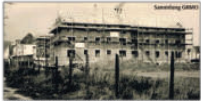
Richtfest am 7. Januar 1958 für die ersten beiden Wohnblocks in der neuen Dillstraße mit 30 Werkwohnungen der bald auf insgesamt 232 Wohnarbeiten anwachsenden Siedlung
