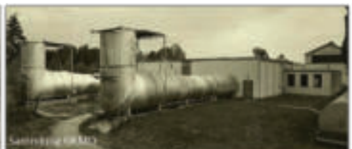
Die beiden Triebwerkprüfstände A1 und A2 mit ihren mächtigen Abgaskanälen an der Rückseite
