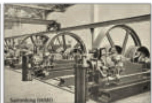
Elektrizitätswerk mit Sauggeneratoren Modell 22
