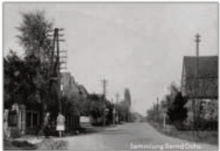
Stromleitungen in der Homburger Landstraße in den 1920er Jahren; Links die Oberurseler Seite mit Holzmasten, rechts die Bommerheimer Seite, mit Ortseingangsschild und ersten Stahlgittermasten
