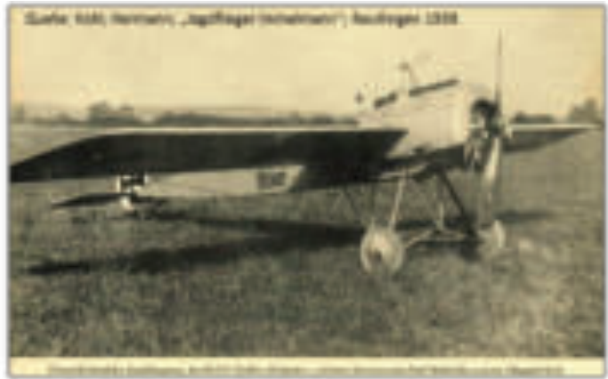
Eindecker E I mit Oberurseler 80 PS-Motor U 0. Erstes Jagdflugzeug mit starr eingebautem, durch den Propellerkreis schießenden MG
