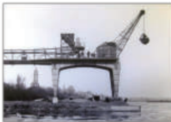
Kohlebösch- und Transportanlage der MKW in Höchst
