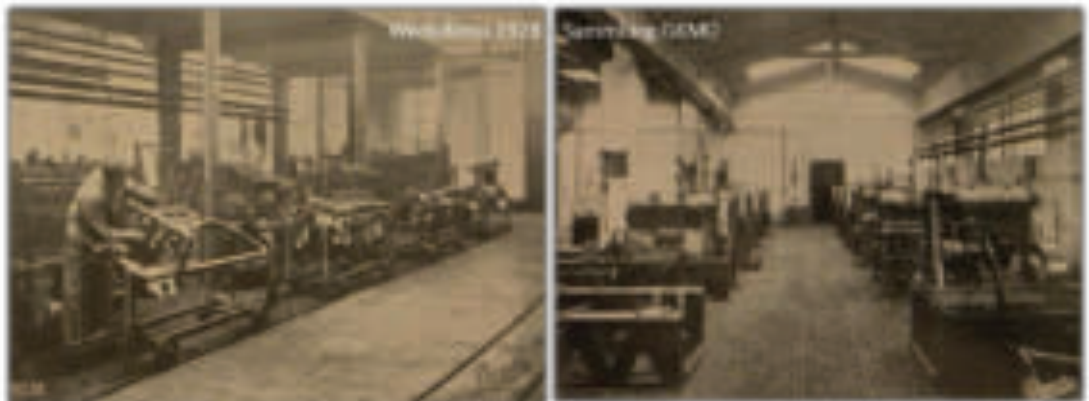
1928 – Motorenmontage auf kippbaren Wagen Prüffeld für Fahrzeugmotoren LM 216 und FM 117
