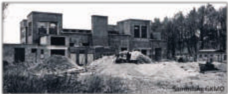
Turmprüfstand während des Umbaus in Fertigungswerkstätten
