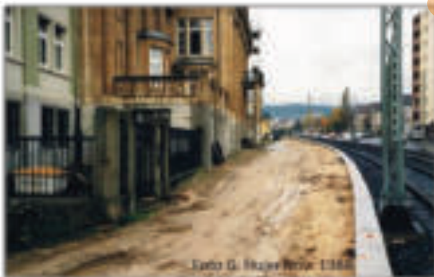
Mit dem neuen Fabrikkörper entsteht eine Einfriedung, welche die Motorenfabrik von der Hohemarkstraße abschneidet
