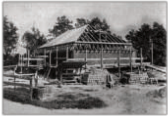
Bau der firmeneigenen Kläranlage 1918 Sammlung GEMO
