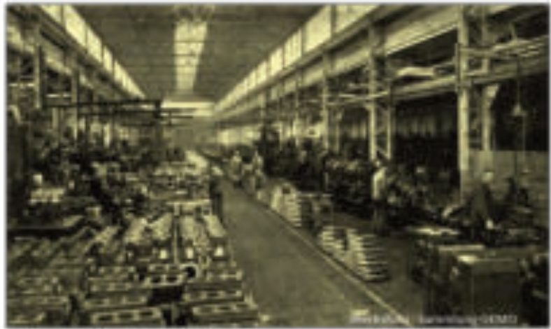
Die große Werkhalle 1938, mit Gehäuse- und Kurbelwellenfertigung
