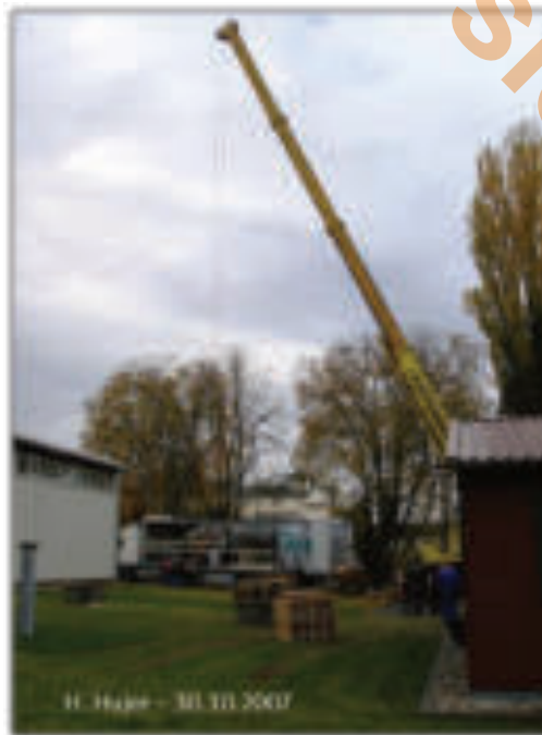
Ankunft im Werk, der Autokran steht bereit
