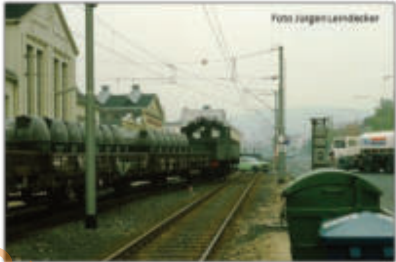
Werkseinfahrt mit Gleisanschluss um 1980 – eine potentielle Gefahrenstelle!
