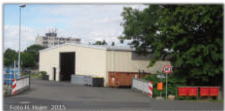
Entsorgungszentrum mit Kalthalle 44 und unterschiedlichen Sammelcontainern
