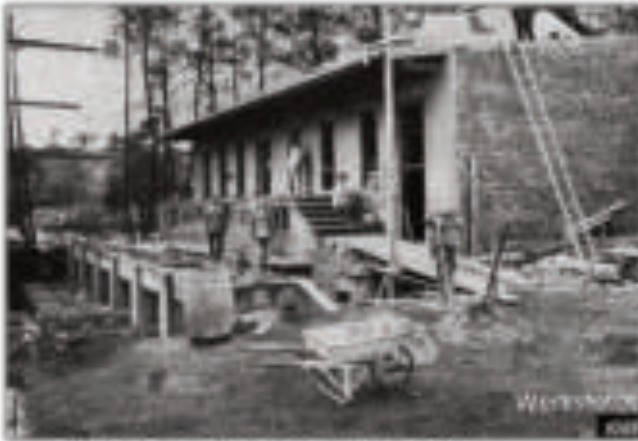
Bau der Tankanlage im Jahr 1917
