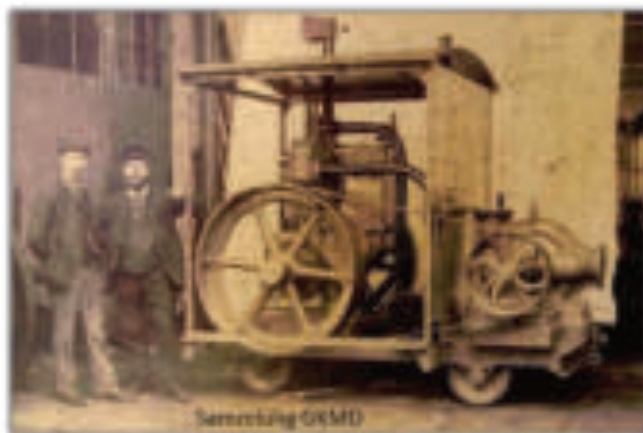
Schienengebundener Pumpenwagen für eine Ziegelei
