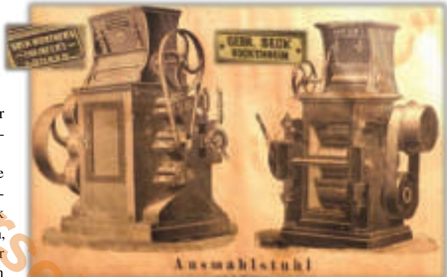
1885 Walzenstühle Gebrüder Seck Bockenheim, hergestellt in Oberursel? Links Exportmodell für England mit Schild Seck Brothers-Engineers-London
