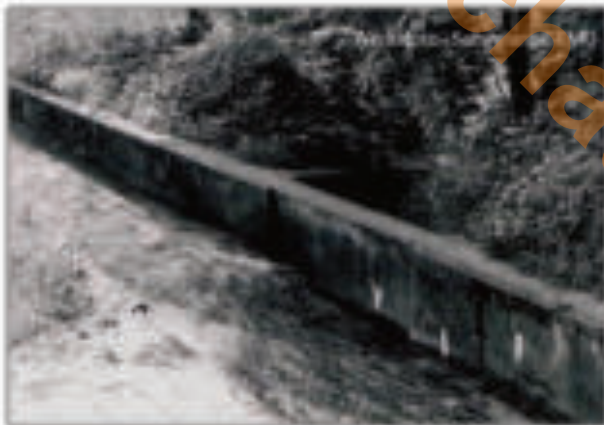
1983 – Die Sohlschwelle im Urselbach leitet die Grundmenge des Wasser noch in den Werkgraben
