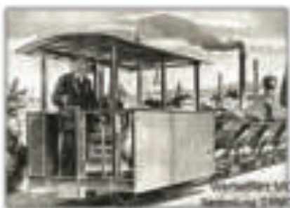
Motorlokomotive der ersten Generation Werkbahn zum Kohletransport
