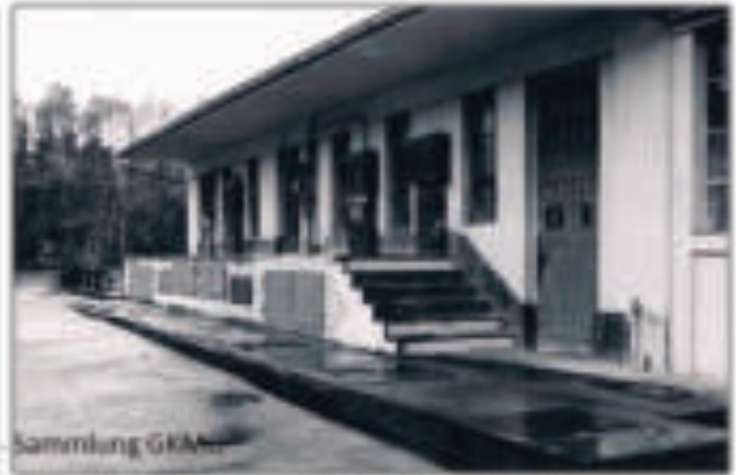
Betriebsgebäude der Tankanlage 1961
