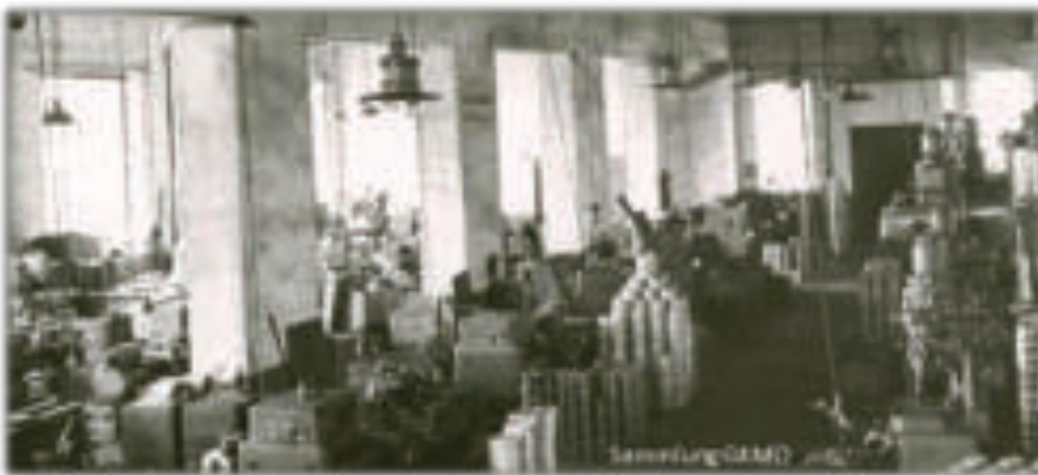
Bearbeitung von Kühlgebläsen im Erdgeschoss des Turmbau um 1951
