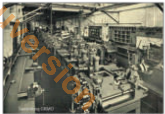
Motorenmontage 1912: Vorn Modell 22, dahinter Modell 24
