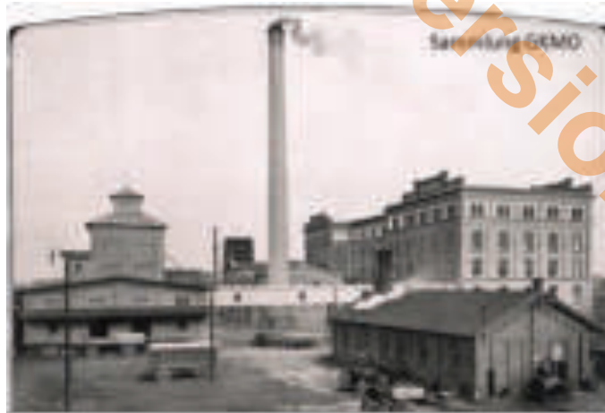
Kraftstation einer Fabrik um 1900, mit Kesselhaus, Schornstein, Dampfmaschinenhaus und Kühlturm
