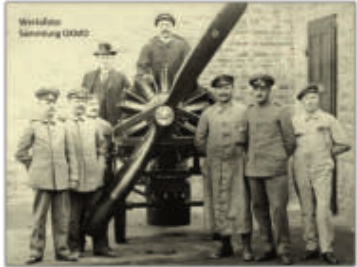
Der 18-Zylinder-Umlaufmotor der Motorenfabrik Oberursel mit 200 PS. Stehend mit Hut vermutlich der Konstrukteur, Oberingenieur Eduard Fraissinet
