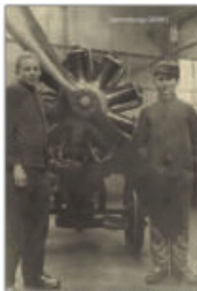
1917 wird überwiegend der UR II gebaut
