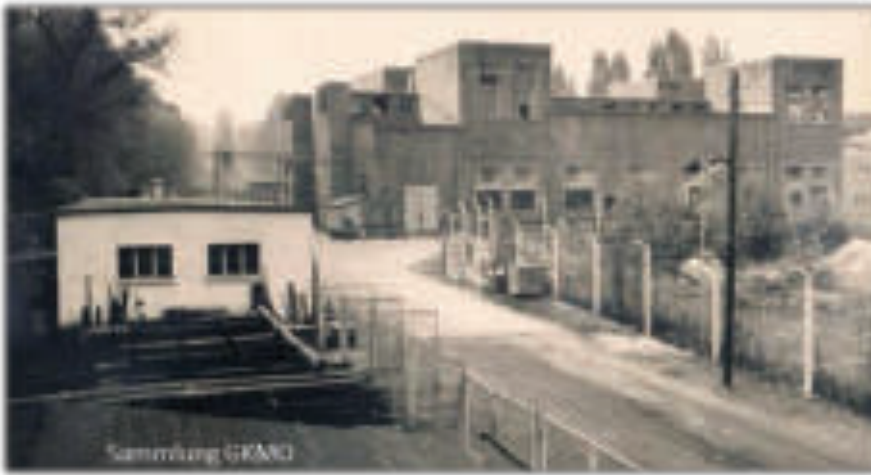
Turmbau 1954 – Neues Stangenmateriallager links, Hofeinfahrt teilweise betoniert, Erweiterung ganz rechts im Bau, neuer Militärzaun um US-Gelände
