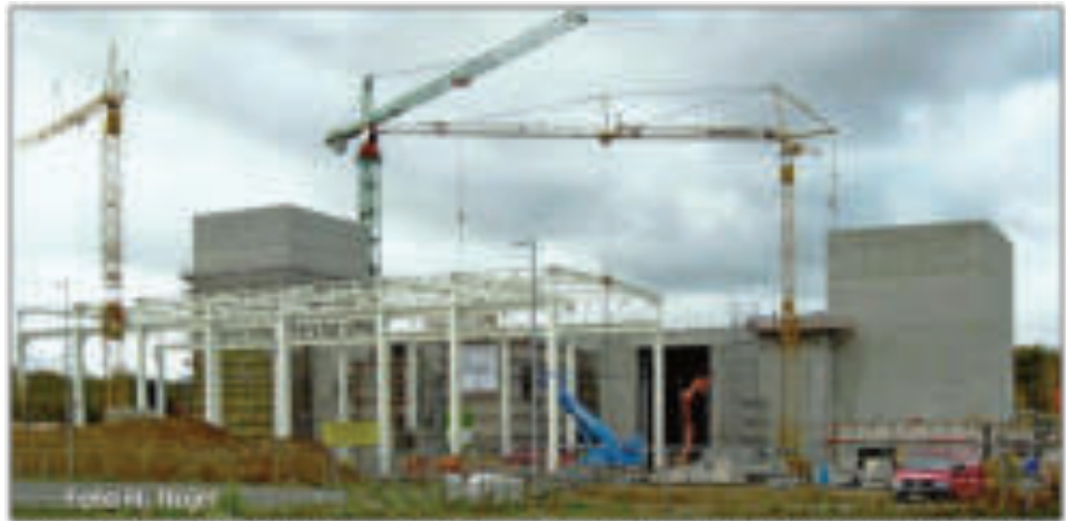
November 2013 - Entwicklungsteststand für Großtriebwerke im Rohbau
