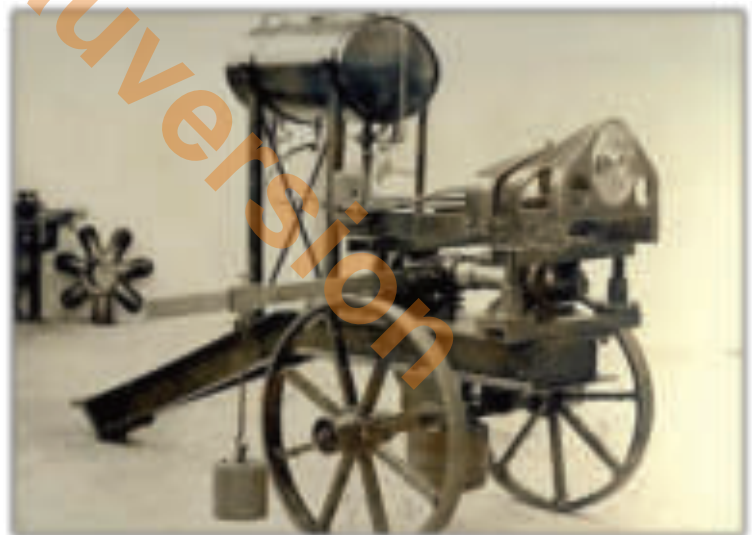
Lafette mit Leistungsmesseinrichtung für die Motorprüfläufe
