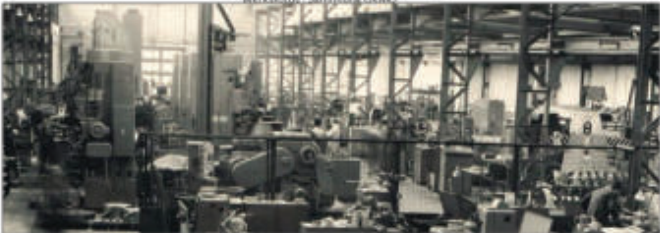
Große Bauteile – große Maschinen, die Großmechanische Fertigung im hohen Schiff der Werkhalle 02 Links hinten zwei Lapointe Räummaschinen, davor Karusselldrehmaschinen, rechts Spezialdrehmaschinen
