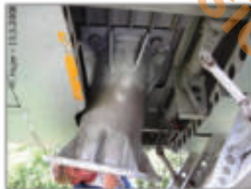
Anflanschen des massiven Stützenoberteils an den im Flügelkasten montierten Verbindungsrahmen
