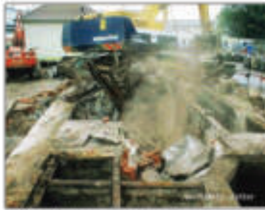
1997 gefundene und abgerissene Abortbecken des 1941 mit dem Pumpenhaus gebauten Kühlsystems
