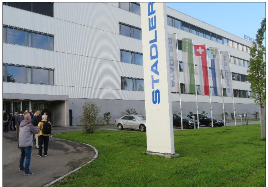
Die GdI zu Gast in den neuen Werksanlagen von Stadler Rail in Sankt Margrethen. Foto: Fabian Jeker.
