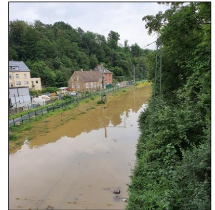
Nach dem Hochwasser am 15. Juli 2021 wurden auch im Bahnhof Bochum-Dahlhausen an der Strecke Essen-Steele Ost – Hattingen (Ruhr) die Gleise überspült; Foto: Wolfgang Dietrich Mann.
