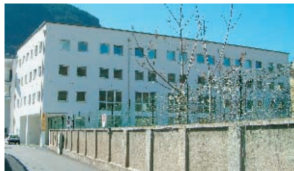
Der neue Sitz des Gemeindenverbandes in der Schlachthofstraße Nr. 4 in Bozen
