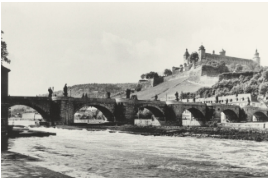
Die älteste Mainbrücke, 1133 erstmals erwähnt, wurde vom Baumeister des Würzburger Doms Enzelin errichtet, um den Fernhandelsverkehr über die Straße vom Rhein-Main-Gebiet um Frankfurt über Würzburg nach Regensburg zu unterstützen. Wahrscheinlich bestand bereits der älteste Bau aus steinernen Pfeilern und Bögen. Die Fürstbischöfe Christoph Franz von Hutten und Friedrich Karl von Schönborn ließen ab 1726 zwölf Statuen errichten.
