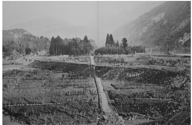
図28-1 小藤文次郎の帝国大学理科大学紀要第5冊4号の「1891年の日本の大地震の原因について」中に掲載された「FAULT」の書き込みのある論文写真
