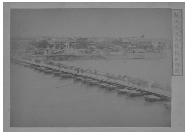
図1 大阪洪水「写真帖」所収の一枚 「明治十八年七月十日難波橋流失ノ後仮船橋之図」（大阪歴史博物館蔵）
