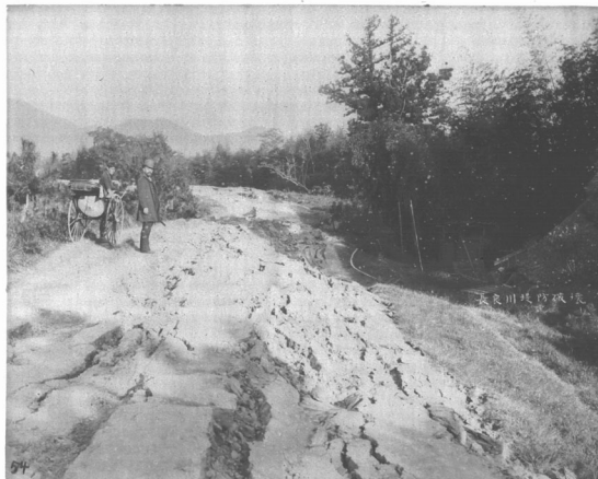
图23 岐阜県厚見郡鏡島村地内長良川通堤防破壊之圖 (宮内庁書陵部蔵)
