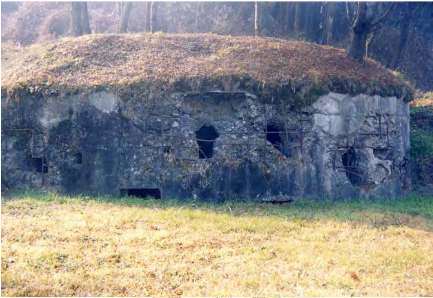
북한군 전차포 사격에 의해 파괴된 국군의 만세교 대전차호 콘크리트 진지
