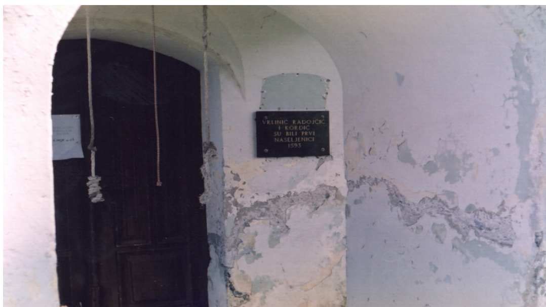
Slika 6: Cerkev v Bojancih pred obnovo (2001)
