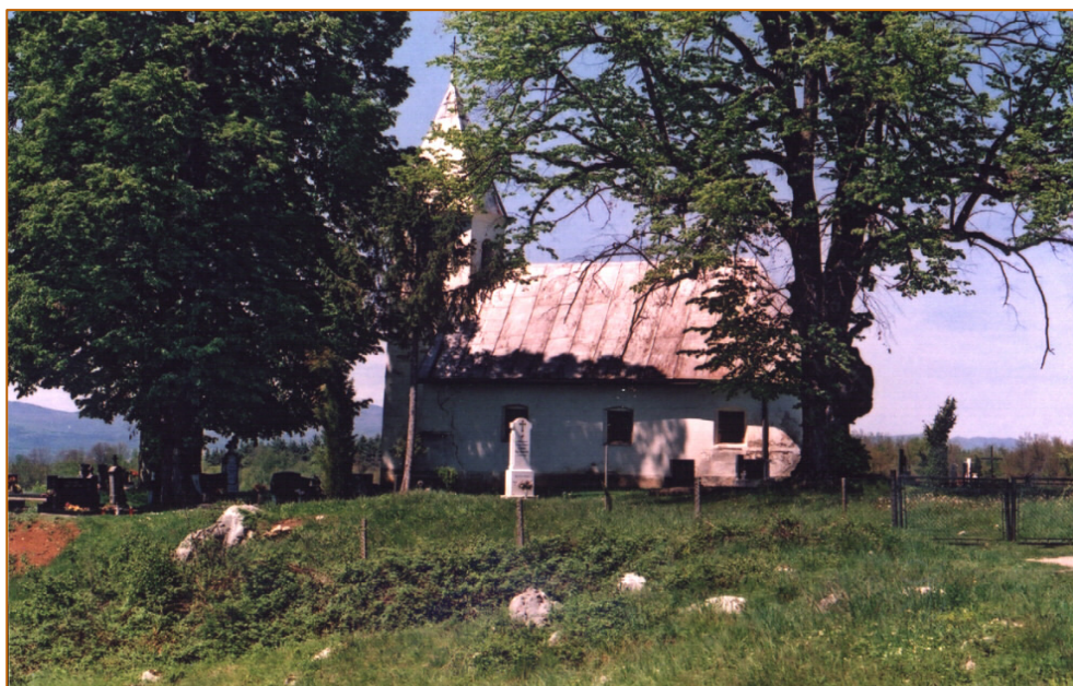
Slika 5: Cerkev v Bojancih pred obnovo (2001)
