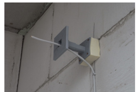
Spezialhalter für die wärmebrückenarme Befestigung von Schaltern und Außenleuchten
