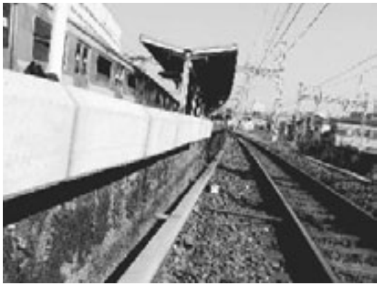
図15 ホーム側面の一部改修後
