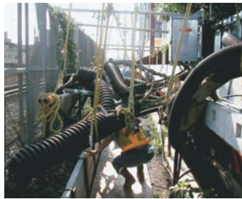
図2 信号ケーブルの沿線敷設
