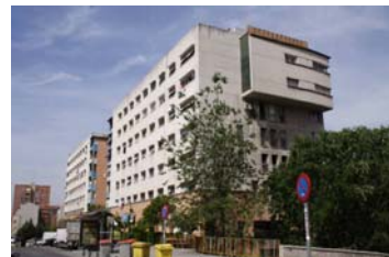
Edificio de 86 viviendas sociales - Sierra Elvira IV Calle Sierra Elvira nº 21-27 Madrid 1987; 1988-1991
