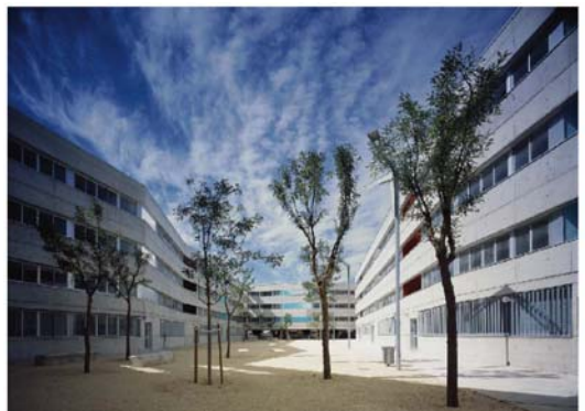
Edificio de viviendas sociales en Rota Carretera de Rota al Puerto de Santa María Rota (Cádiz) 1996-1998; 2001-2004 Concurso Nacional de Anteproyectos. Primer premio
