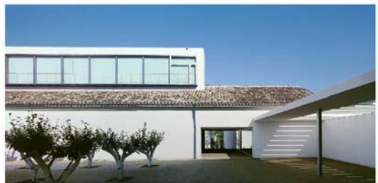
Ayuntamiento de Tomares. Rehabilitación de la Hacienda Santa Ana Calle de la Fuente s/n 1995-1998; 2000-2004
