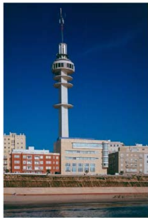
Torre de Telecomunicaciones y edificio de servicios telefónicos Paseo Marítimo. Cádiz 1989; 1991-1993
