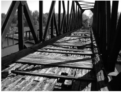
Die stillgelegte Brücke der ehemaligen Friedhofsbahn über den Teltowkanal. (Quelle: KAS)
