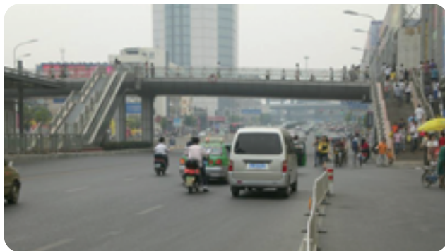
新しい歩道橋 新建成天桥
