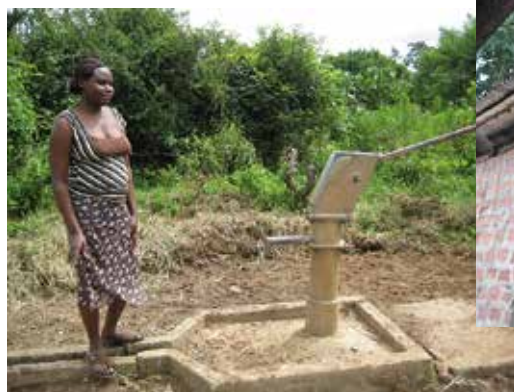
壊れている井戸。 これから住民たちの貯めた資金で井戸修理を行う
