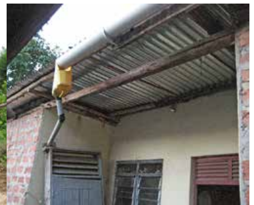
村人自ら、屋根に樋をつけ家の中に雨水を貯める工夫が凝らされている
