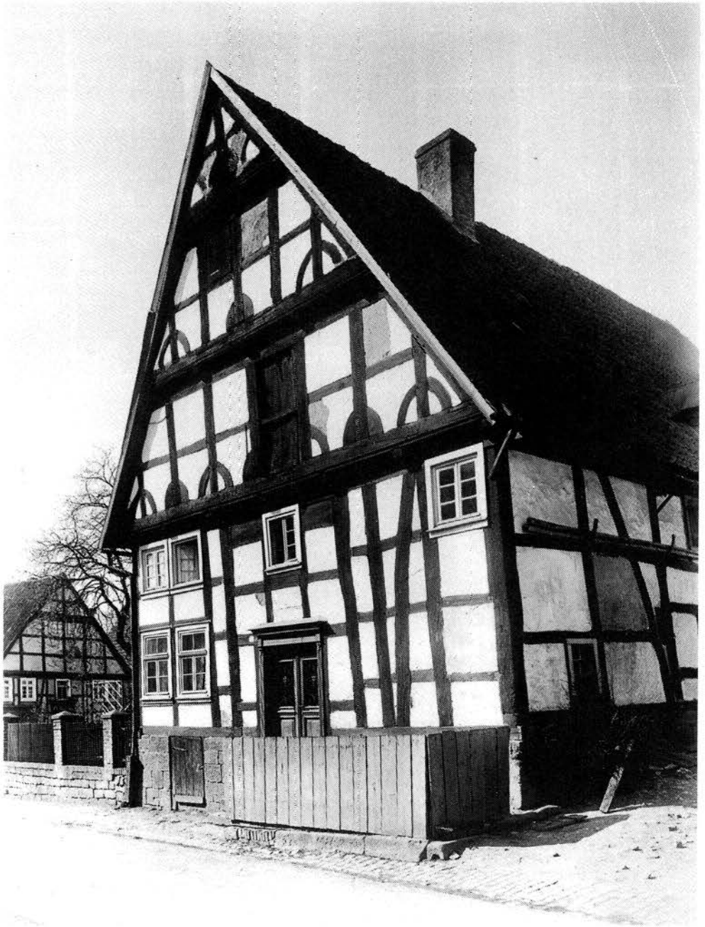
Abb 46 Rüthen, Mittlere Straße 1 (1550-1600).
