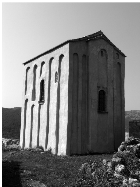
Sv. Mihailo u Stonu, pogled sa jugoistočne strane
