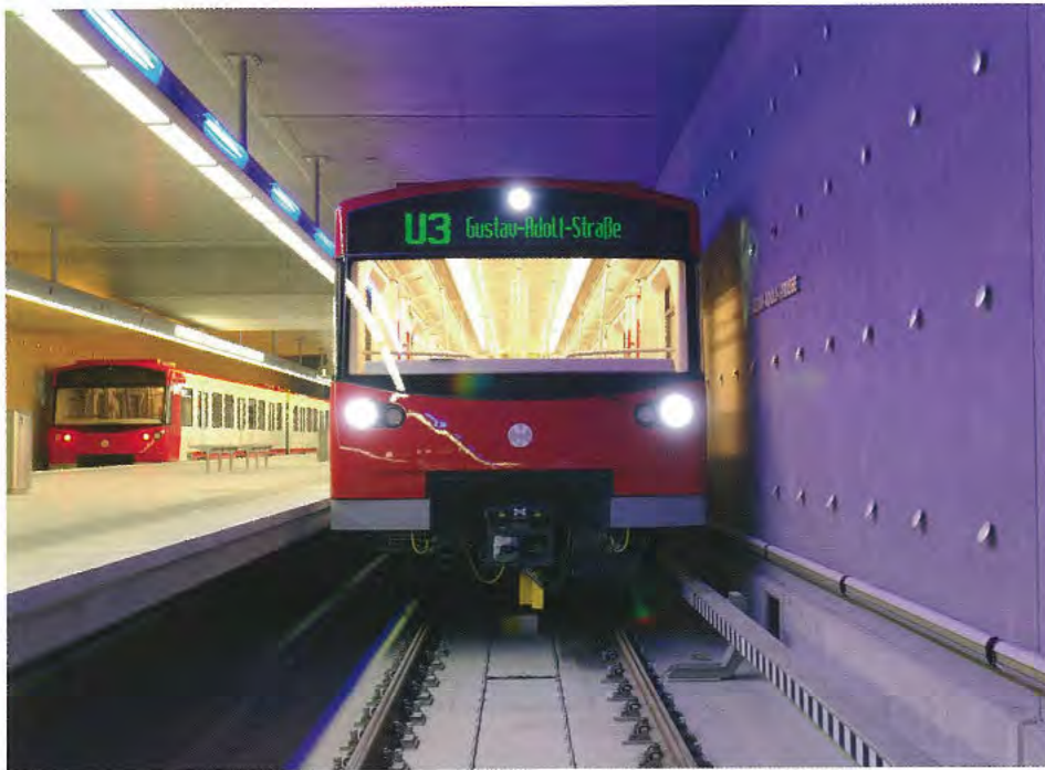
Zwischen den Schienen liegen die Linienleiter, über die die Fahrzeuge Informationen mit dem Streckenrechner austauschen. Hier der U-Bahnhof Gustav-Adolf-Straße.
