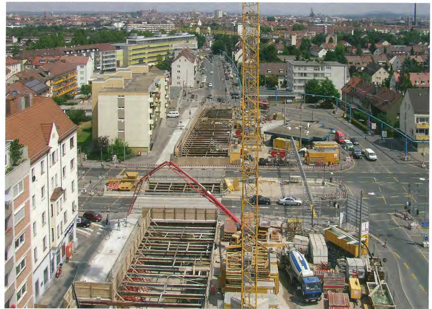
Ungewohnter Blick aus der Vogelperspektive: Die Baugrube des Bahnhofs Gustav-Adolf-Straße in der Wallensteinstraße.
