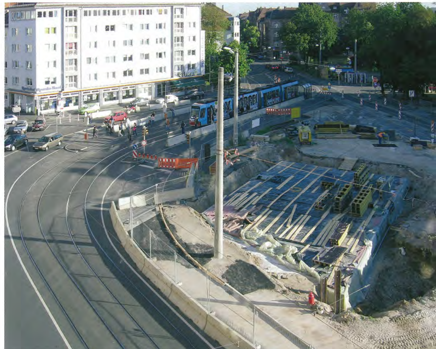
Vor Rohbaubeginn werden am Friedrich-Ebert-Platz alle Ver- und Entsorgungsleitungen aus dem Baufeld für den U-Bahnhof herausgelegt (links).
