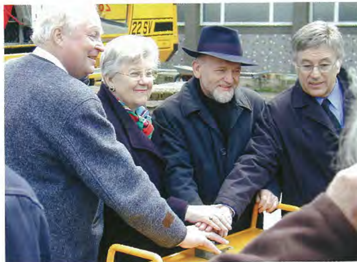
23.04.2001 Oberbürgermeister Ludwig Scholz gibt beim Bahnhof Maxfeld mit Bürgermeisterin Helene Jungkuntz, dem Baureferenten Walter Anderle und Dieter Klinger als Vertreter der bauausführenden Arbeitsgemeinschaft das Startsignal für den ersten Rammschlag auf der U 3-Nordwest.
