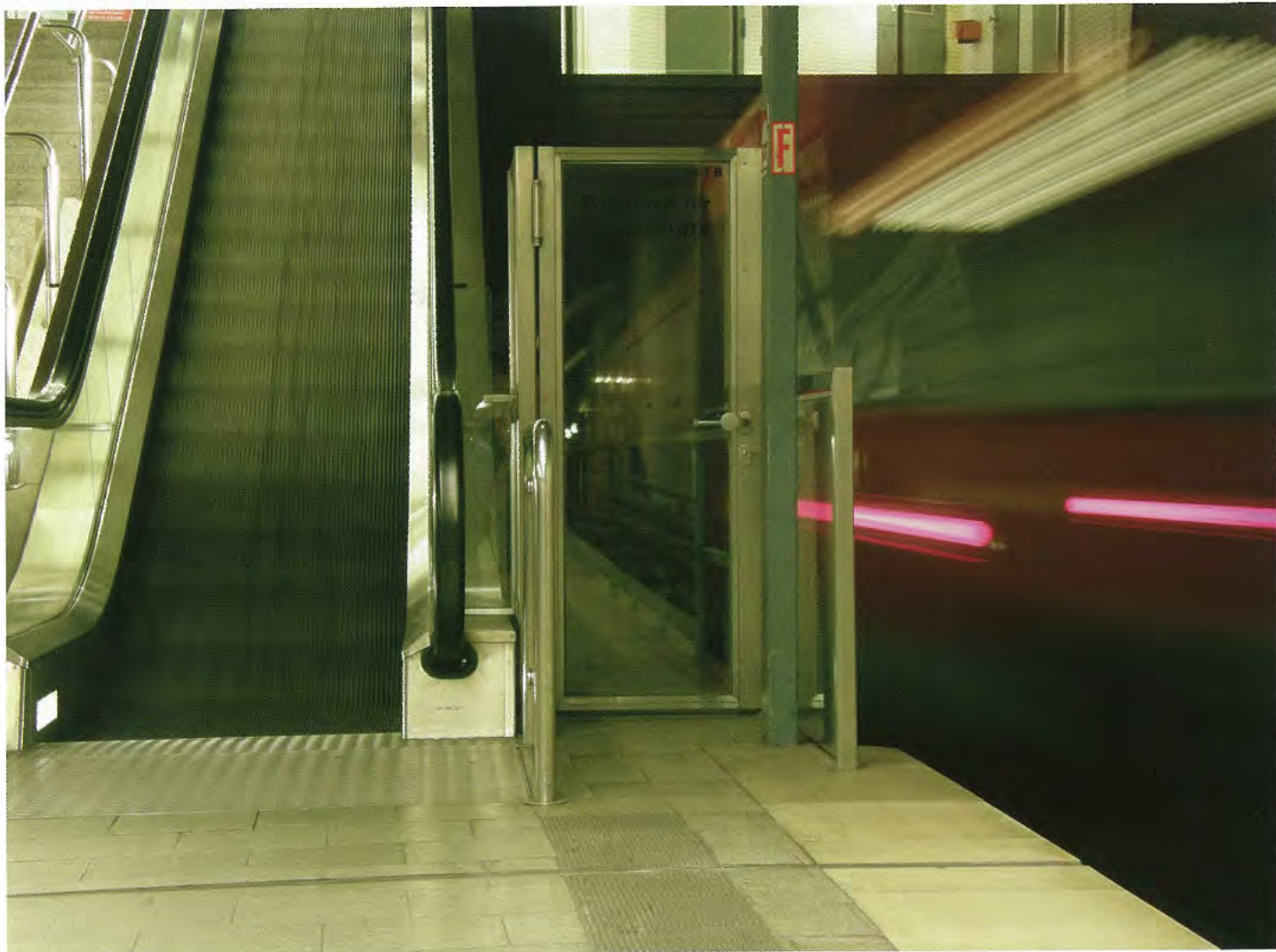
Anpassung an die neue Technik: Mit den neuen Bahnsteig-Abschlussstüren ist der U-Bahnhof Rathenauplatz für den automatischen Betrieb fit gemacht worden.
