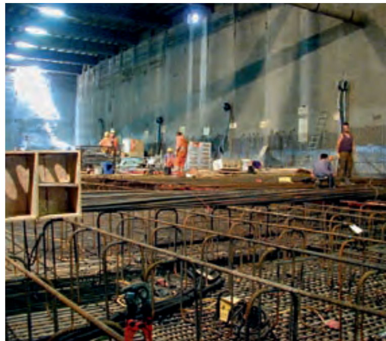
Vor dem Betonieren der Sohle musste die Bewehrung eingebracht werden.
