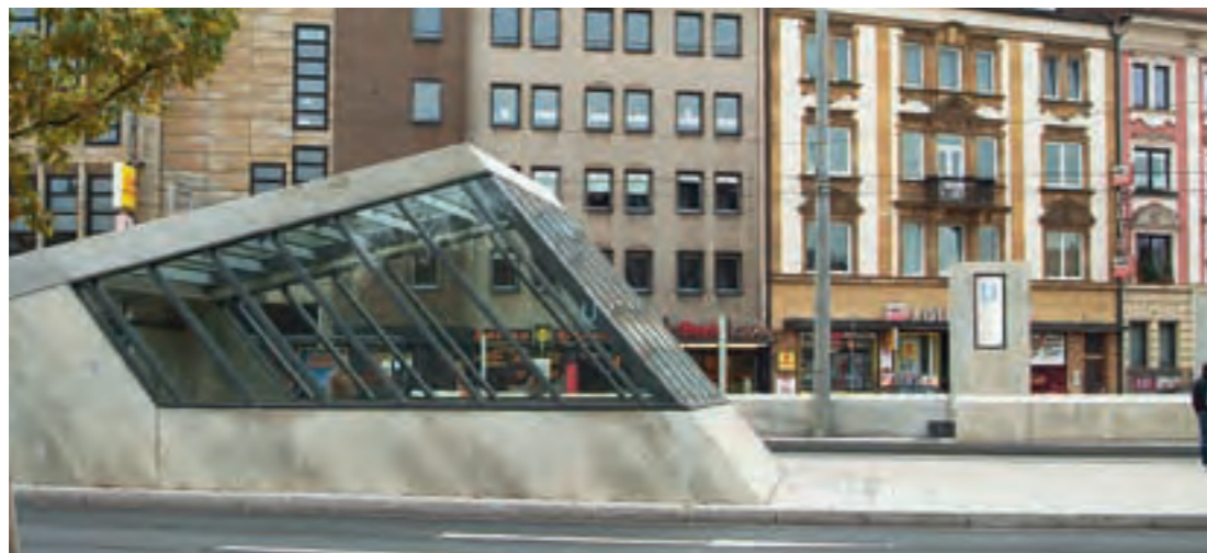
Der Aufgang vom U-Bahnhof Friedrich-Ebert-Platz zur Straßenbahnhaltestelle ist zugleich Lichtschleuse.
