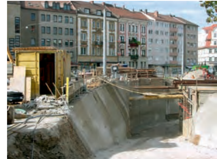
Über die Rampe am Ostkopf des Bahnhofs Friedrich-Ebert-Platz wurde das Aushubmaterial abgefahren.
