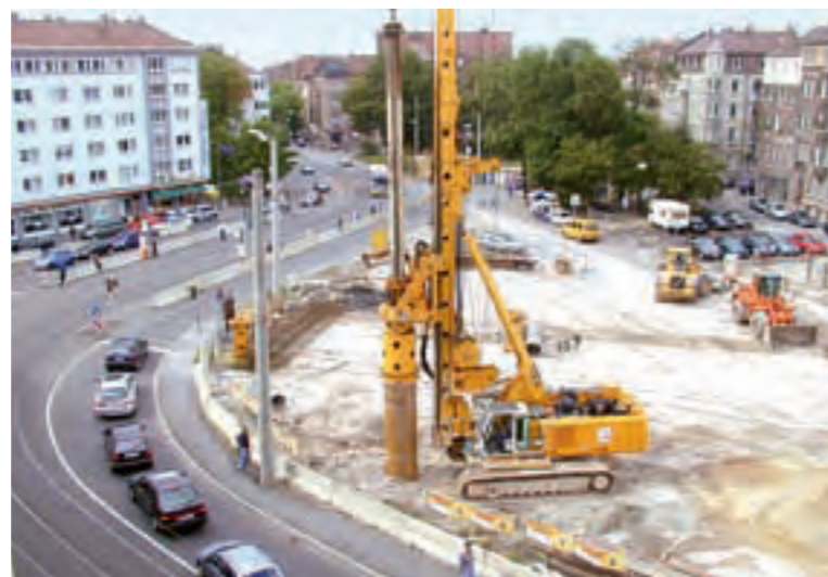
Einbringen der Bohrpfähle sowie umgelegte Straßenbahn zu Beginn der Bauarbeiten.
