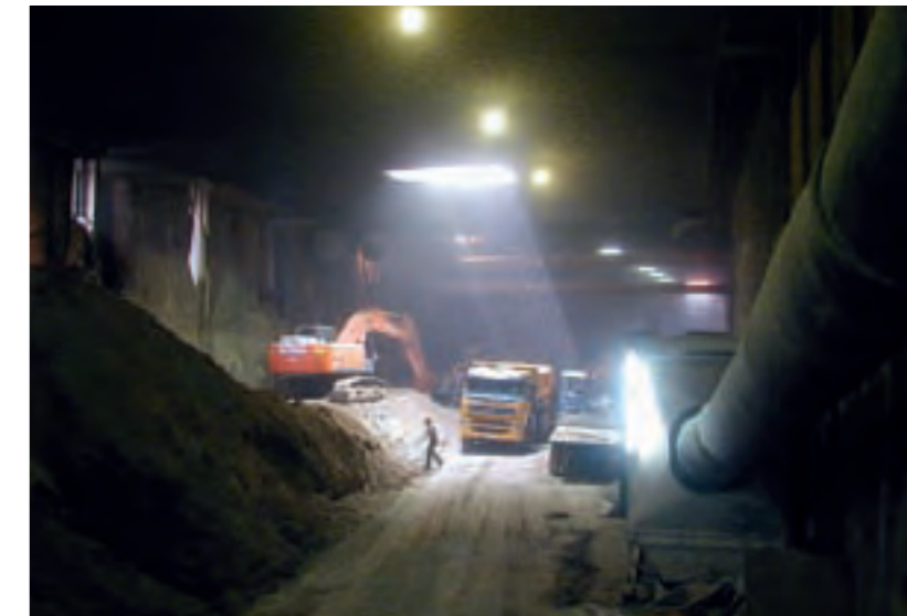
Durch die Deckelbauweise konnte das Erdreich unterirdisch abgetragen werden, während oberirdisch der Verkehr ungehindert floss.
