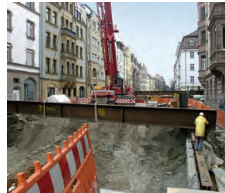
Enge Angelegenheit: Die massiven Stahlträger für den Deckel auf der Baugrube wurden passgenau an Ort und Stelle gehoben.
