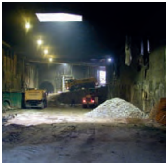
Blick auf die Rampe, über welche der Aushub abtransportiert wurde.
