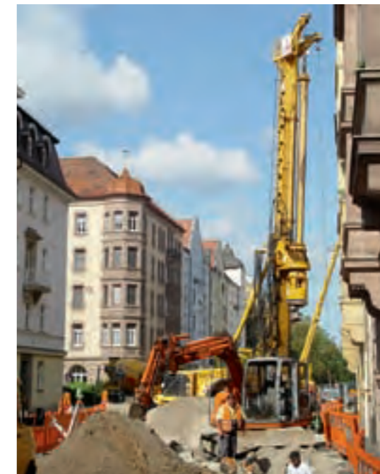
Schweres Gerät vor historischer Kulisse: Der Einbau einer Betonpfahlwand schützt die denkmalgeschützten Häuser.
