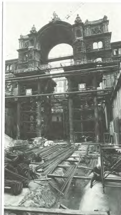
Die Mittelhalle des Hauptbahnhofs wurde abgebrochen und das Portal blieb auf Stelzen erhalten, bis die Bauarbeiten für die unterirdische Station ausgeführt waren.
