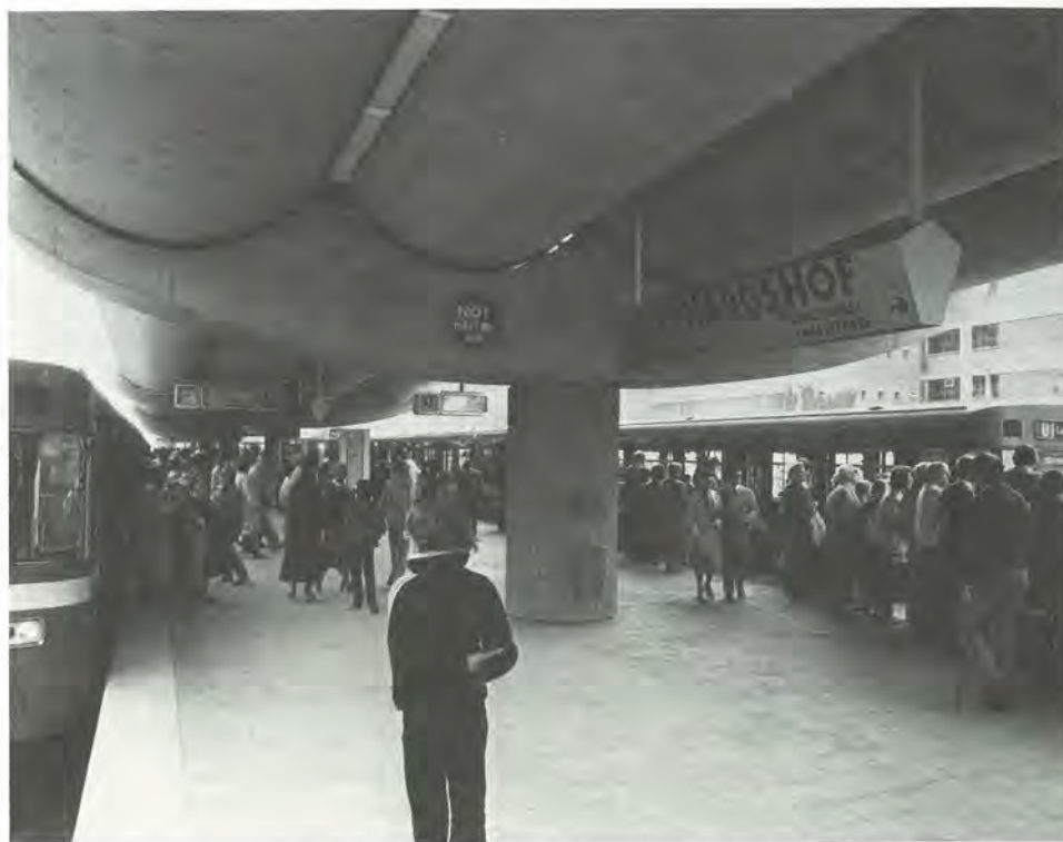
Bisheriger Endpunkt der U-Bahn war der oberirdische Bahnhof Eberhardshof mit seinem charakteristischen Wellendach aus Betonschalen.
