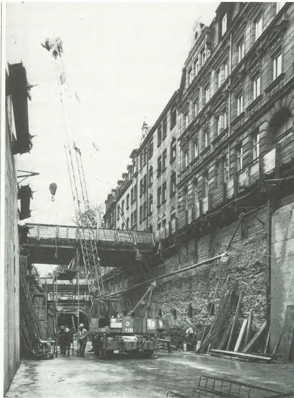
Der Bahnhof St. Leonhard und die anschließende Tunnelstrecke werden in der Schweinauer Straße in offener Bauweise errichtet (oben). Von diesem Schacht (rechts) aus werden die beiden Tunnelröhren in Richtung Nopitschstraße bergmännisch aufgeföhren; hier entsteht später der Westkopf des Bahnhofes Schweinau.
