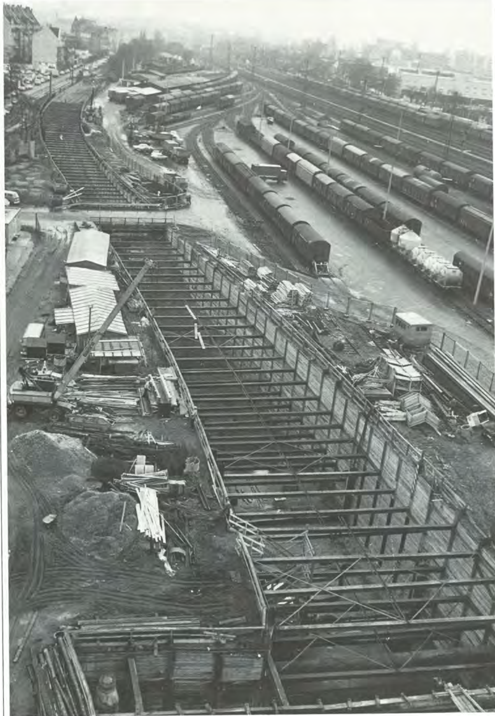
Südlich der Nürnberger Straße, bereits auf Fürther Stadtgebiet, liegt der Bahnhof Stadtgrenze. Er schließt an das westliche Ende der Hochbahnbrücke an und befindet sich auf einem Damm mit einer Höhe bis zu sechs Metern. 90 Meter messen die Bahnsteige, die ein zickzackförmiges Faltdach aus Stahlbeton vor Regen und Schnee schützt. Auch hier verbindet ein Fußgängertunnel die Station mit den Gehwegen der Nürnberger Straße. Behinderte und Frauen mit Kinderwagen können die Bahnsteige über einen Aufzug erreichen.
