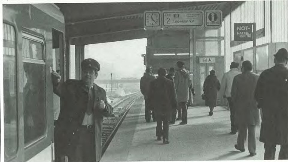
Die Hochbahnbrücke (oben) überspannt links die Zufahrt zum Frankenschneidweg und rechts die südliche Fahrbahn der Fürther Straße. Der erste Bahnhof der neuen Strecke ist Muggenhof (unten).
