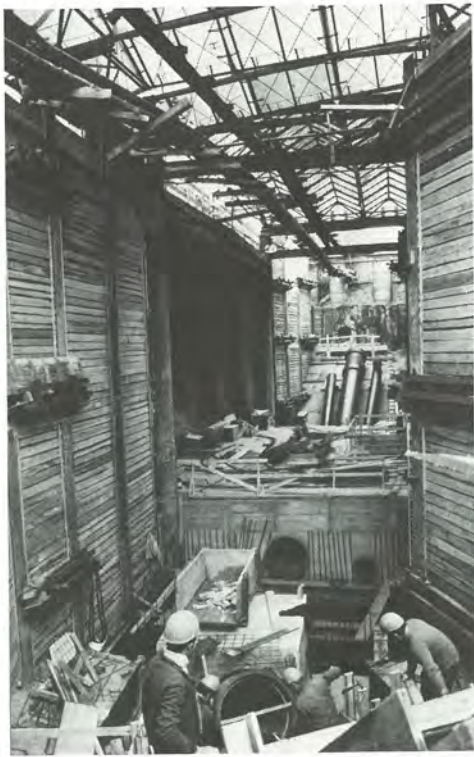
Beim Bau des unterirdischen Bahnhofs Jakobinenstraße mußte der kreuzende Schmutzwasserkanal als Düker unter dem Bauwerk durchgeführt werden (oben). Die Rampenstrecke, rechts noch im Bau, verläuft in einem S-Bogen auf dem ehemaligen Ladehof der Bundesbahn zur Gebhardtstraße
