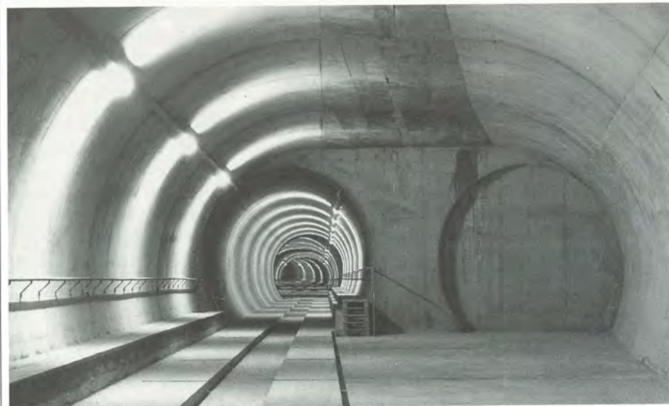
Der Bahnhof Rothenburger Straße der U 2-Süd wurde bergmännisch hergestellt. Das Bild oben zeigt einen Blick in die Bahnsteigröhre mit dem Querschlag zum Nachbargleis, das Foto unten die trompetenförmige Aufweitung der U-Bahn-Röhren hinter dem Bahnhof. Die beim Bau vorgesehene Fortsetzung der U2 in Richtung Gustav-Adolf-Straße ist rechts erkennbar.
