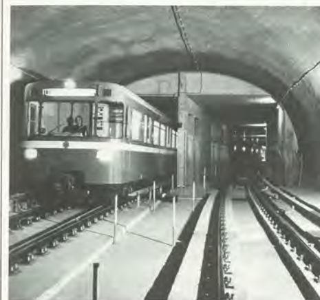
Die U-Bahn-Linie 1 fährt in Langwasser oberirdisch (oben) und verläuft dann unterirdisch. Auf Höhe der Frankenstraße geht der Rechtecktunnel in den bergmännisch aufgefahrenden zweigleisigen Tunnel unter dem Hasenbuck über (unten).
