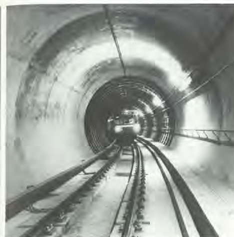
Ein U-Bahn-Zug an der Nahtstelle zweier Bautechniken: Hinten wurde bergmännisch aufgefahren, vorne in der „Neuen Österreichischen Tunnelbauweise“ gearbeitet.
