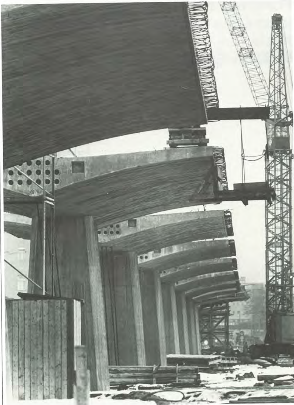
Bereits 1969 wurde die Hochbahnbrücke mit ihren symmetrischen Kragträgern, die durch gleichlange Einhängeträger verbunden sind, gebaut. Auf dieser Brücke fuhr übergangsweise bis 1981 die Straßenbahn.
