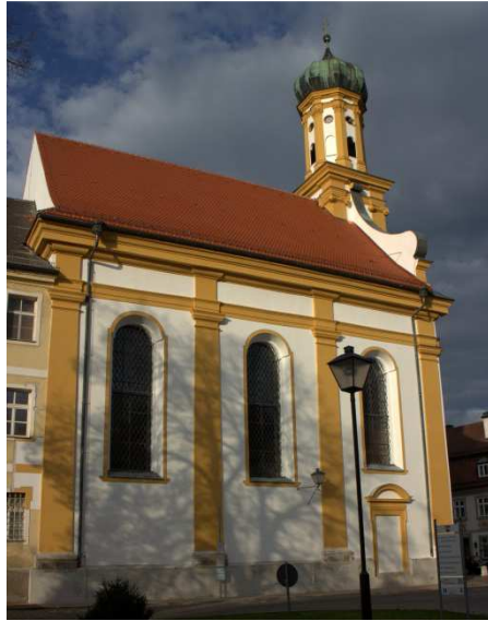
Foto vom Verfasser Abb. 25 b: Ostseite der ehem. Klosterkirche, mit renovierter Fassade
