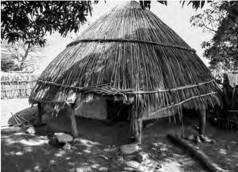
Fig. 52 Photographie de la case peul H3 en bauge de terre de termitière et latérite (photo T. Pelmoine)
