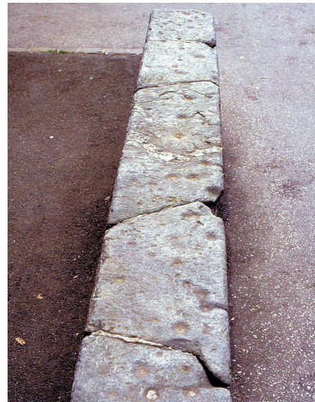
Abb. 26. Etwa 60 Schalen auf der Mauer vor der Kirche San Carlo Borromeo von Lugaggia (Carpriasca CH). 16. Jahrhundert.
