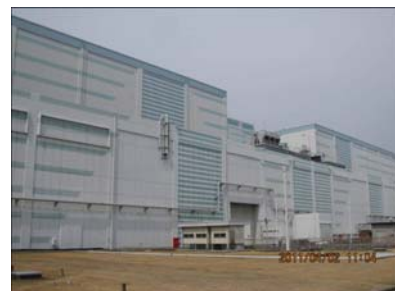
3, 4号機タービン建屋 (津波浸水の痕跡無し)
