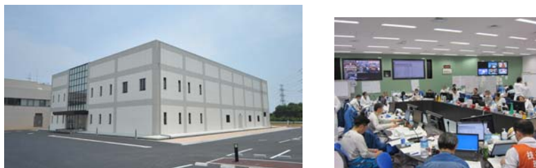
免震重要棟(左:外観、右:緊急対策本部)
