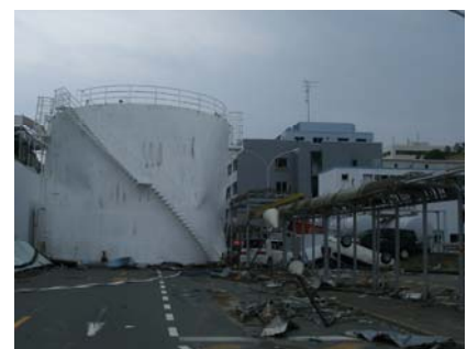
津波で流されて道をふさいだ重油タンク (直径11.7m×高さ9.2m)
