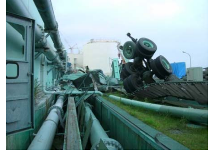
4号機タービン建屋東側
