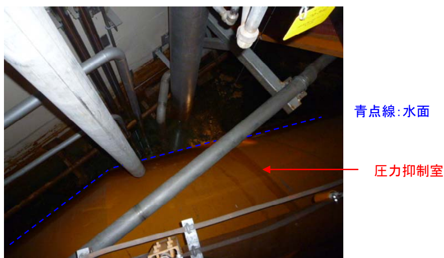
4号機トラス室キャットウォークから真下を撮影
