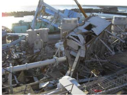
5号機海側海水ポンプエリア
