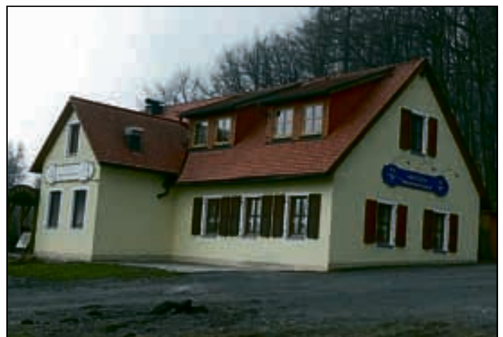
Das ehemalige Mesner- und Schulhaus auf dem Armesberg wurde im Laufe der Zeit umgebaut und restauriert.
