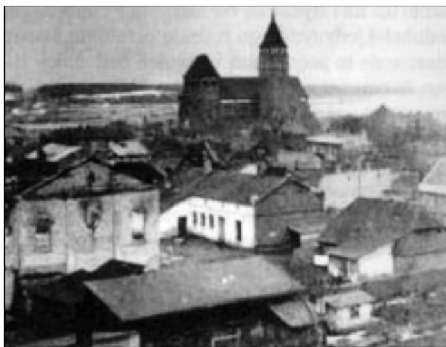
Szczytowa ściana podpalonej bożnicy. Zdjęcie wykonane przez żołnierza Wehrmachtu w lutym 1940 r. Zbiory Lecha Borzyma
