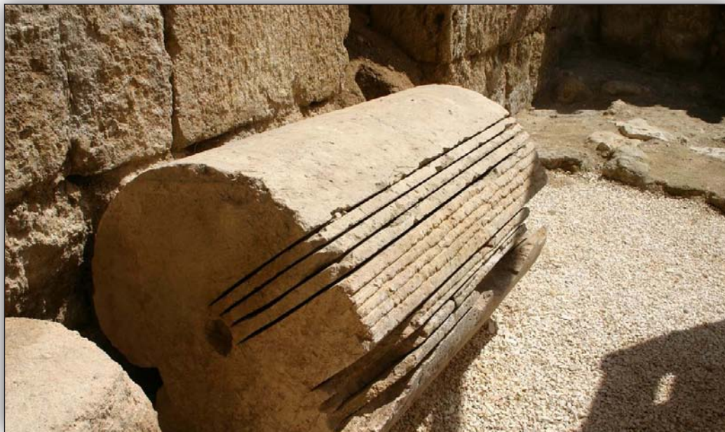
02- Gerasa. Huellas en una columna antigua reutilizada, realizadas por una sierra con cuatro hojas de corte tensadas en un marco múltiple (siglo VI d.C.).
