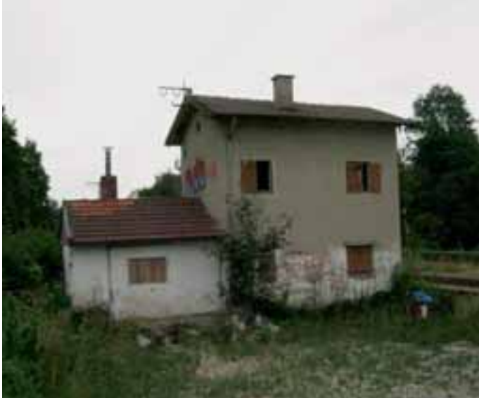
Bahnwärter-Häuschen: Heruntergekommen und zukunftslos
