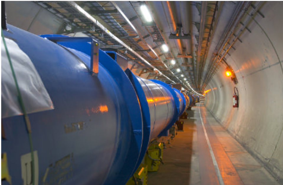
Abbildung 44: Innenansicht des LHC-Tunnels.
