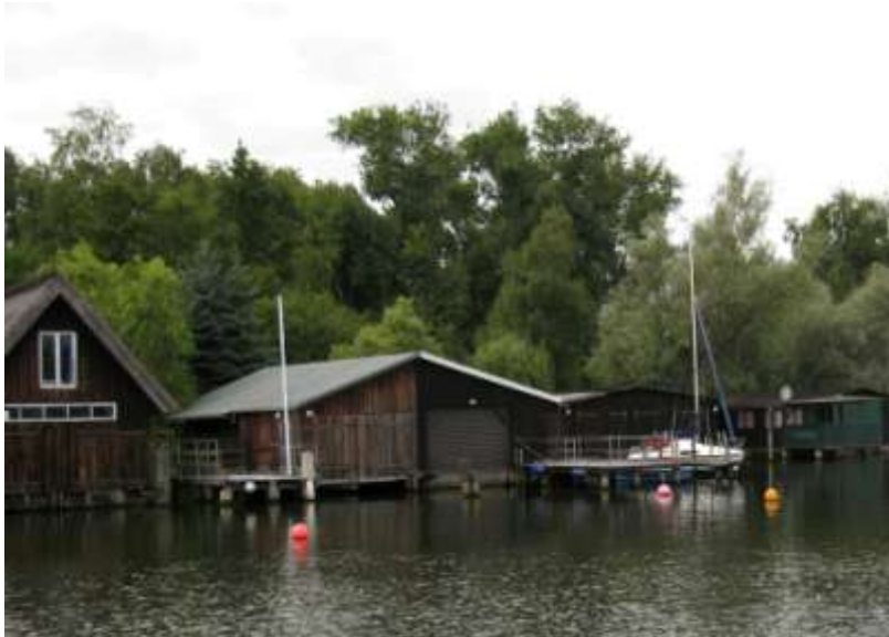
Abb. 59: Bootsschuppen, teilweise mit Ferienwohnungen.
