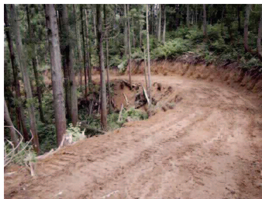
【写真】 開設が進む森林作業道の状況
