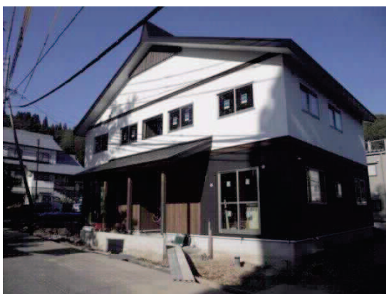
【写真】 村内における木材利用の状況 (震災復興村営住宅)
