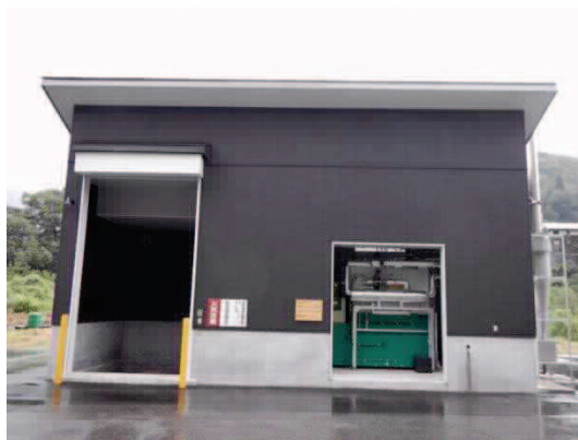
【写真】 北野天満温泉のチップボイラー
