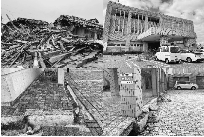
志賀町の地震被害
