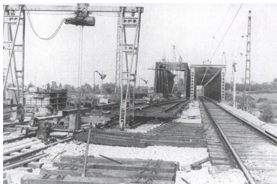
Bau der zweiten Bregenzerachbrücke, 1960
