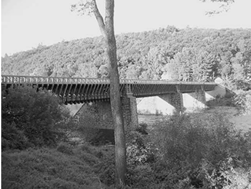
Bild 7: Kanal-Aquädukt über den Delaware. Erbaut von Röbling im Jahre 1848. Nach seinem ursprünglichen Erscheinungsbild unter Verwendung der Originalkabel wiederhergestellt. Foto: Kahlow 2004.
