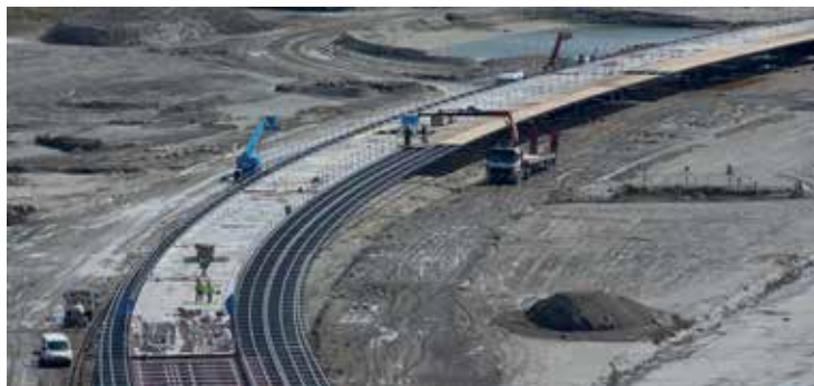
9 Einzelne Arbeitsschritte der Überbauerstellung © schlaich bergemann und partner/Michael Zimmermann
