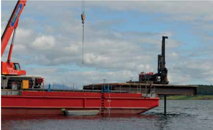
6 Bohrarbeiten zur Herstellung der Steel Core Piles © Bilfinger Tresfjordbridge
