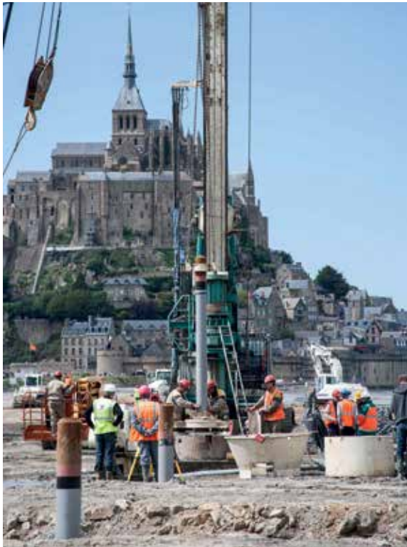
11 Bohrarbeiten der Pfähle und Justierung der Stützen © schlaich bergemann und partner/Michael Zimmermann
