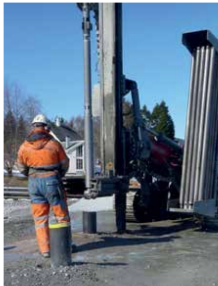
4 Herstellung der Stahlkernpfähle (links) und schematischer Aufbau von Stahlkernpfählen (rechts) © Bilfinger Tresfjordbridge
