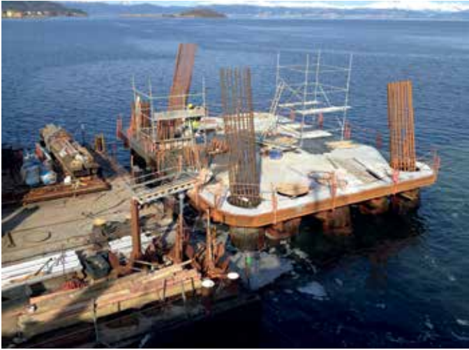
11 Bewehrungsarbeiten und Ausbetonieren der Stahlrammpfähle © Bilfinger Tresfjordbrücke
