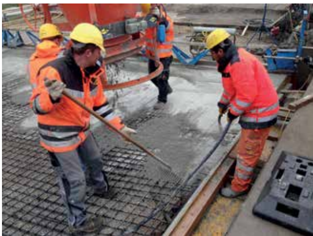
13 Betonieren und Verdichten der unteren Lage des UHPFRC-Aufbetons einschließlich Überkronung © ASFINAG Bau Management GmbH
