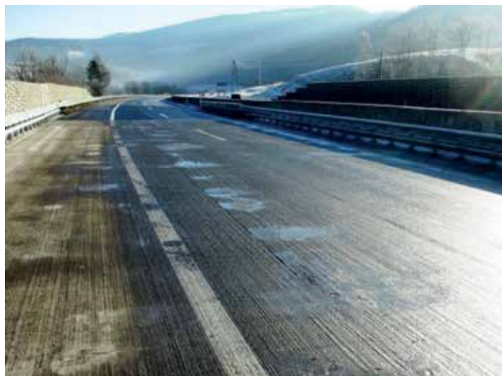
15 Fertiggestellte Tragwerks- und Fahrbahnoberfläche © ASFiNAG Bau Management GmbH
