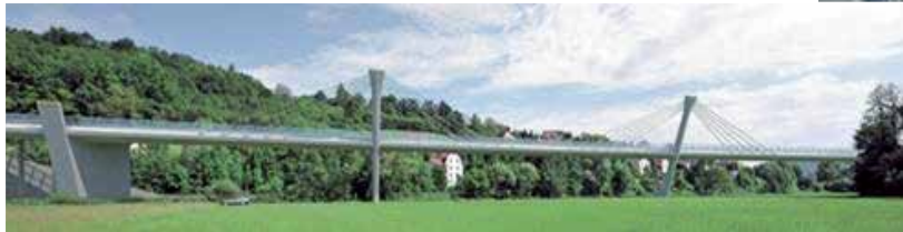
Talbrücke über die Schorgast, Erster Preis
