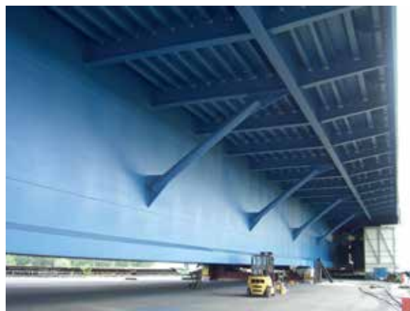
10 Überbau im Kragarmbereich © Landesbetrieb Mobilität Rheinland-Pfalz
