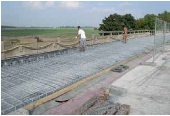
10 Einsatz von feuerverzinktem Bewehrungsstahl an Brückenkappen © Industrieverband Feuerverzinken e.V.
