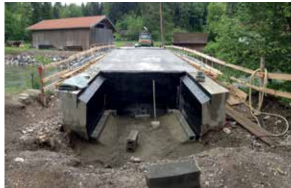
12 Herstellung des Aufbetons aus Leichtbeton © Zilch + Müller Ingenieure GmbH
