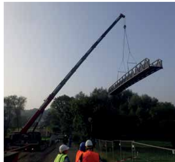
Einheben der komplett vorgefertigten Segmente © Technische Betriebe Solingen
