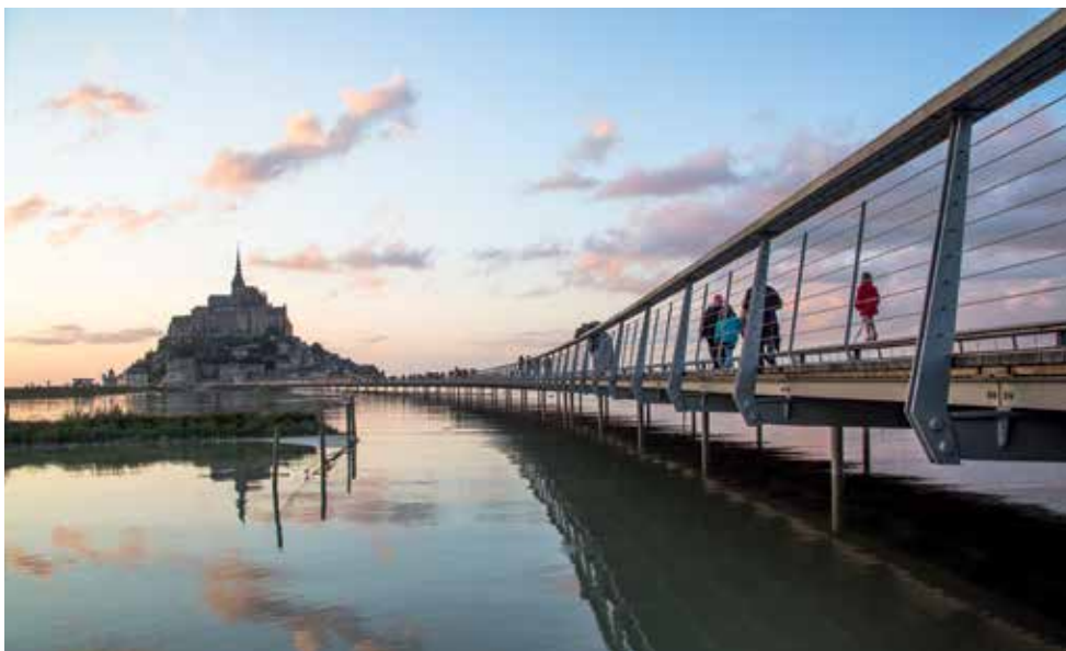
3 Leichtes, stegartiges Erscheinungsbild der Brücke bei Flut © schlaich bergemann und partner/Michael Zimmermann
