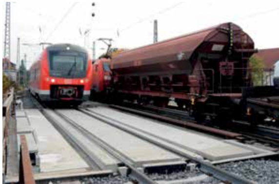
2 SLEP-Brücke: Fertigteilüberbau mit integrierter Schienenbefestigung © Zilch + Müller Ingenieure GmbH
