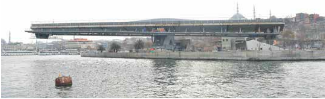
3 Drehbrücke in halbgeöffnetem Zustand © Ludwig Barger
