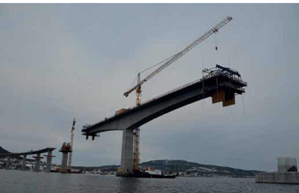
19 Symmetrischer Freivorbau (Waagebalkenprinzip) auf Achse 7 © Bilfinger Tresfjordbridge
