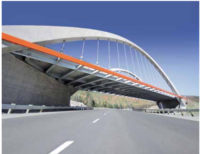
1 Stoneham-Brücke in Quebec mit feuerverzinkten Stahlbauteilen und feuerverzinktem Bewehrungsstahl © American Galvanizers Association
