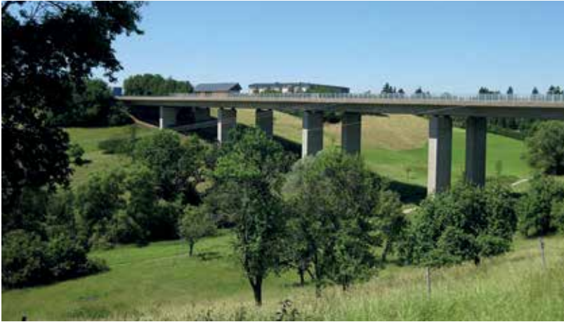
15 Pfaffentalbrücke: Bestandsbauwerk © Autobahndirektion Nordbayern
