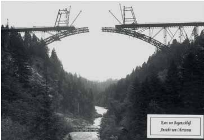
3 Errichtung des Stahlgerüstbogens im Freivorbau © Staatliches Bauamt Weilheim
