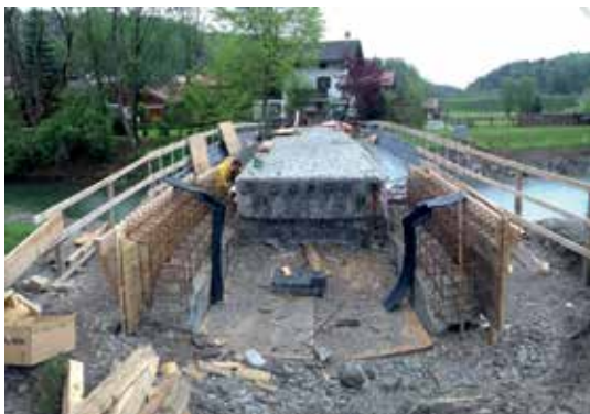
11 Restquerschnitt nach erfolgreichem Abbruch mit freigelegten Spannköpfen © Zilch + Müller Ingenieure GmbH
