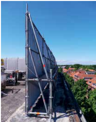
Hochbunkergerüst mit Cisilent®-Elementen © Calenberg Ingenieure GmbH
