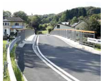
Fahrbahn aus Gussasphalt © Ingenieurbüro Miebach
