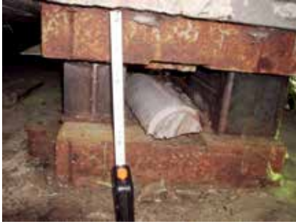
3 »Explodierte« Rolle: auf Notstapeln aufsitzender Überbau © Maurer AG
