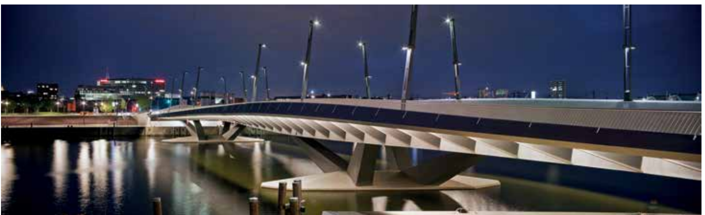
5 Beleuchtung des Bauwerks bei Dunkelheit © Hafencity Hamburg GmbH/Wilfried Dechau
