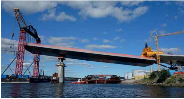
12 Einhub einer Sektion © Firmengruppe Max Bögl
