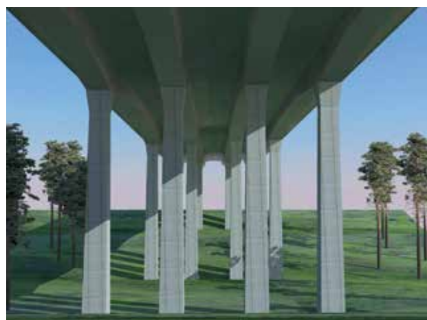
8 Untersicht des integralen Bauwerks © Autobahndirektion Nordbayern
