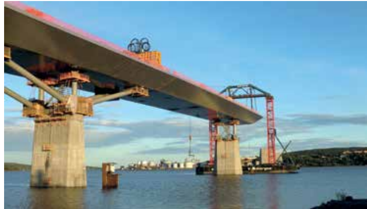
13 Abgeschlossener Sektionseinhub © Firmengruppe Max Bögl
