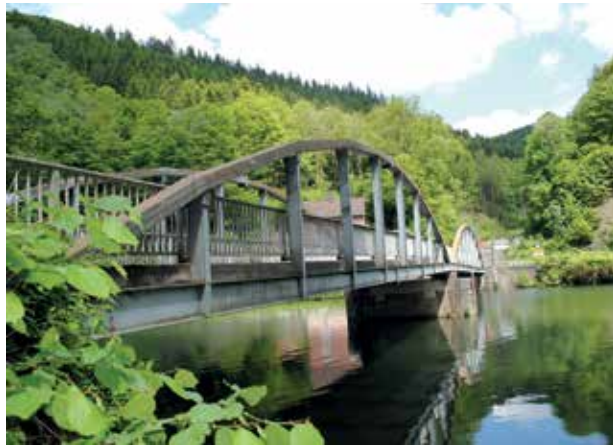
7 Feuerverzinkte Höllmecke-Brücke von 1987 © Institut Feuerverzinken
