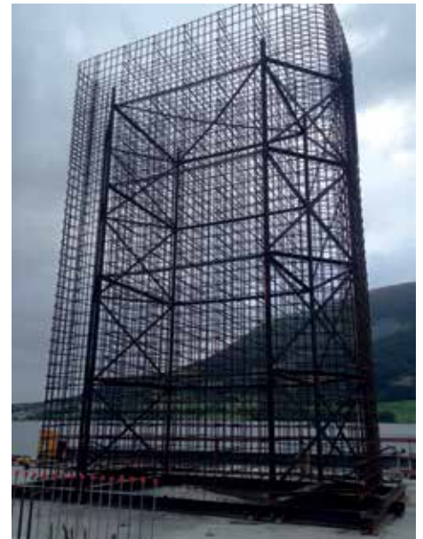
7 Vorgefertigte Fundamentbewehrung mit aussteifendem Stahlrahmen © Bilfinger Tresfjordbridge
