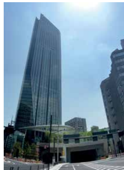
■ Stadthöchstes Gebäude direkt über einer Hauptstraße © Getzner Werkstoffe GmbH
