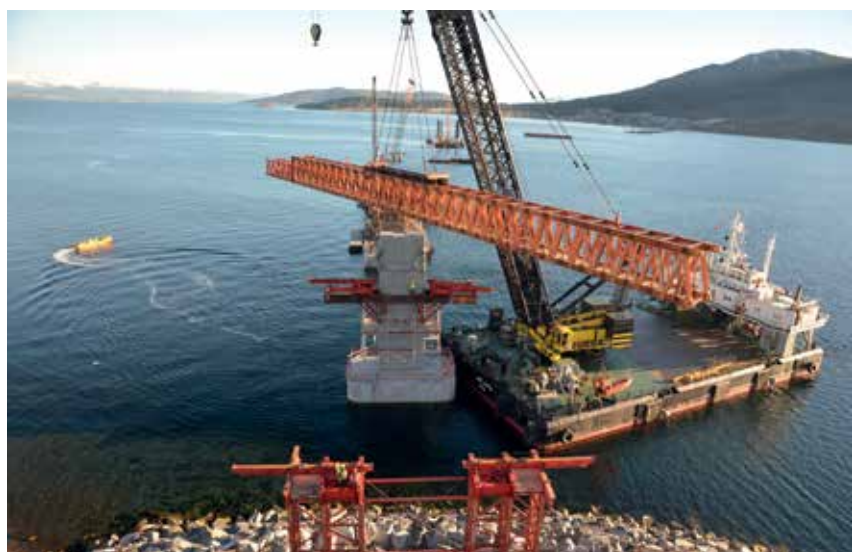
17 Aufbau der Vorschubrüstung mit Schwimmkran © Bilfinger Tresfordbridge
