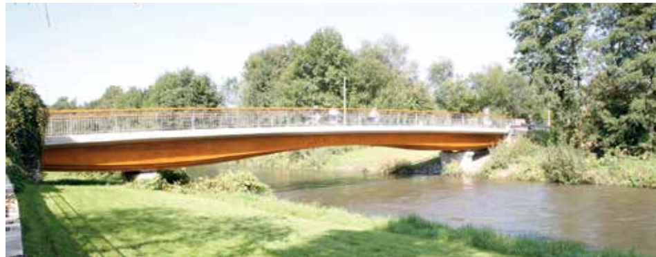
Flussquerung in Holz-Beton-Verbundbauweise © Ingenieurbüro Miebach
