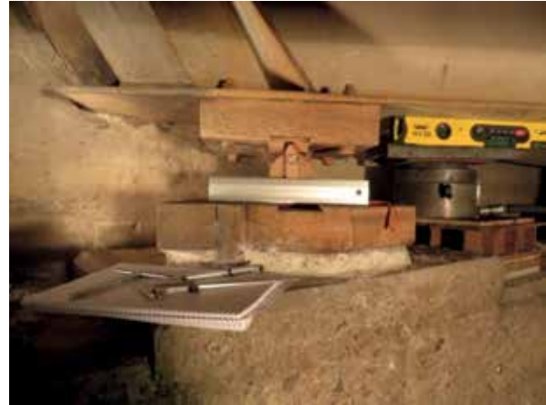
19 Vermessen der Bestandsrollenlager © Maurer AG
