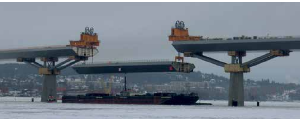
14 Lückenschluss mit der Sektion 6 © Firmengruppe Max Bögl
