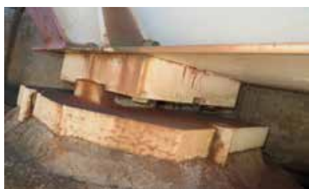
7 Festpunktlager mit Dollen und Schrauben zur Befestigung und Horizontalkraftabtragung © Maurer AG
