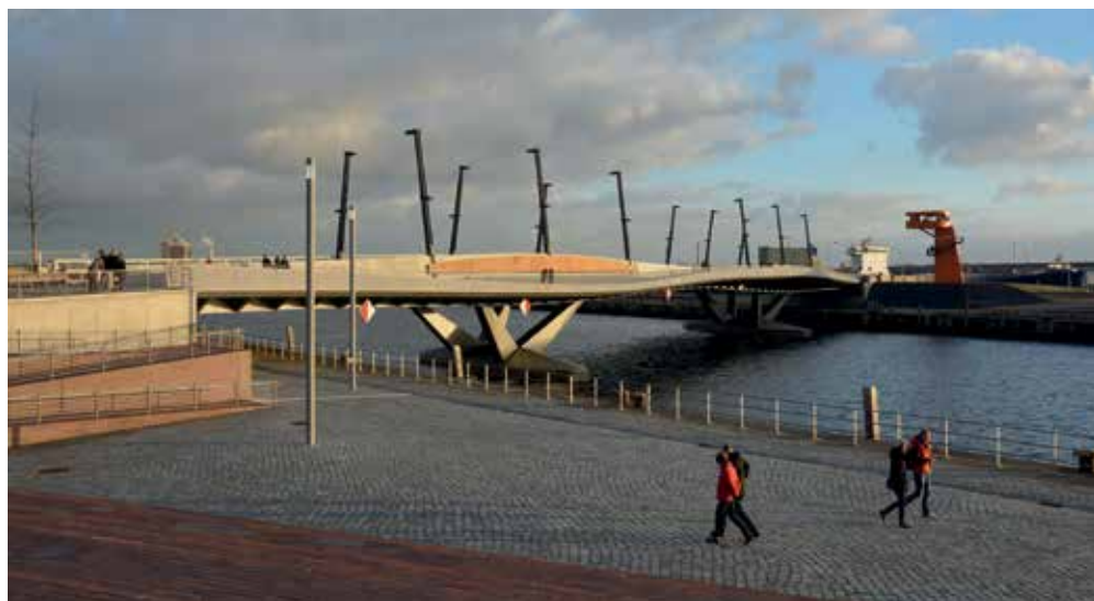
2 Baakenhafenbrücke in der HafenCity Hamburg © HafenCity Hamburg GmbH/Elbe & Flut/Tobias Hampel
