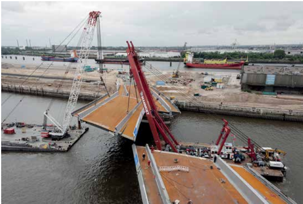
9 Montage mit Schwimmkränen © Hafencity Hamburg GmbH/Wilfried Dechau
