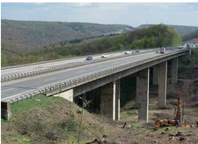
3 Talbrücke Rohrbuch: Bestandsbauwerk © Autobahndirektion Nordbayern
