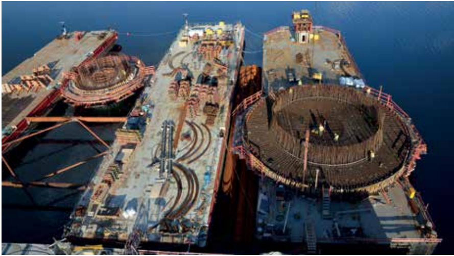
13 Frei schwimmender Caisson für Achse 7 zwischen zwei Pontons (links), Caissonbodenplatte für Achse 8 auf absenkbarem Ponton (rechts) © Bilfinger Tresfordbridge
