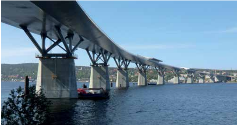
15 Brücke nach dem Abschluss der Stahlbaumontage © Firmengruppe Max Bögl
