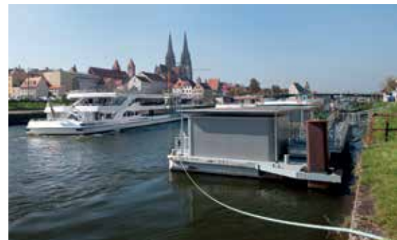
Zweiter Preis: Errichtung einer Schiffsanlegestelle in Regensburg © inrotec Ingenieurbüro für Innovative. Rohr. Technologien GmbH
