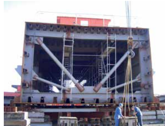
9 Zusammenschweißen eines Hohlkastens © Landesbetrieb Mobilität Rheinland-Pfalz
