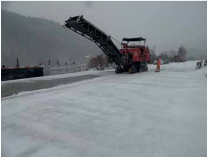
14 Fräsen der Betonoberfläche © Philipp Hadl/Technische Universität Graz
