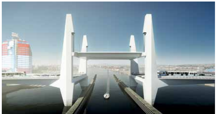
5 Vier Hubtürme mit zentralem Hubfeld © Dissing + Weitling architecture a/s
