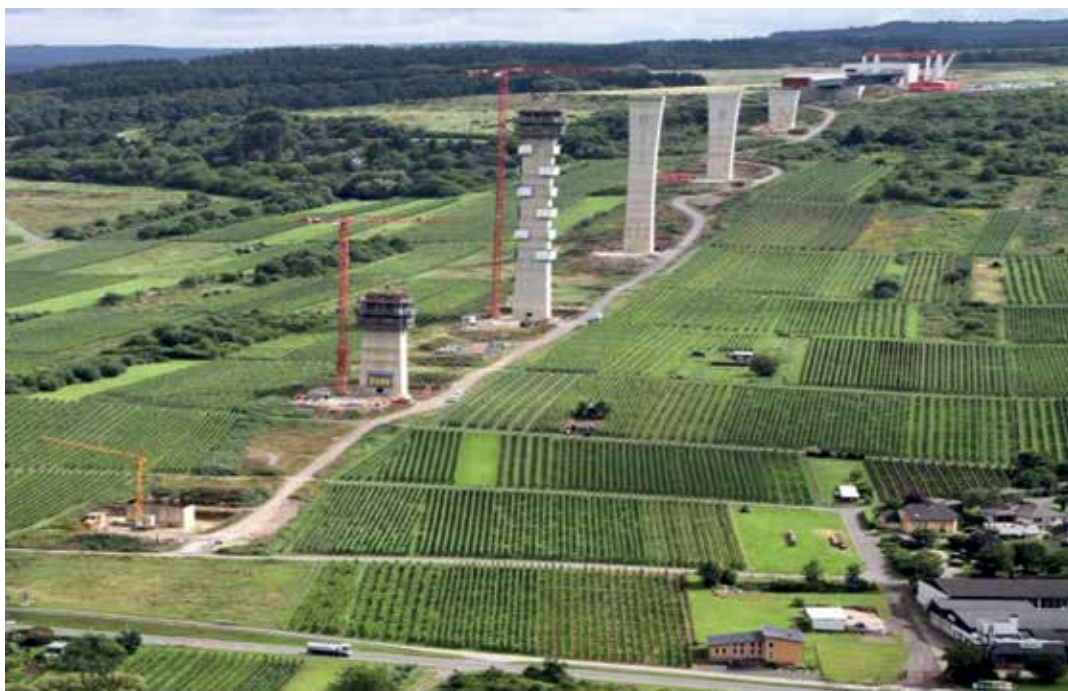
13 Herstellung der Pfeiler im Hang © Landesbetrieb Mobilität Rheinland-Pfalz
