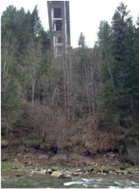
6 Situation: FFH-Gebiet im Bereich der vorhandenen Brücke © Staatliches Bauamt Weilheim
