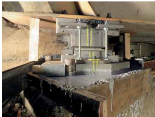
20 Eingebautes Kalottensegmentlager, Herstellung der unteren Vergussfuge © Maurer AG
