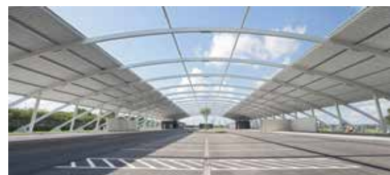
Sonderpreis: Überdachung eines Großmengenwertstoffhofes in München © AJG Ingenieure GmbH
