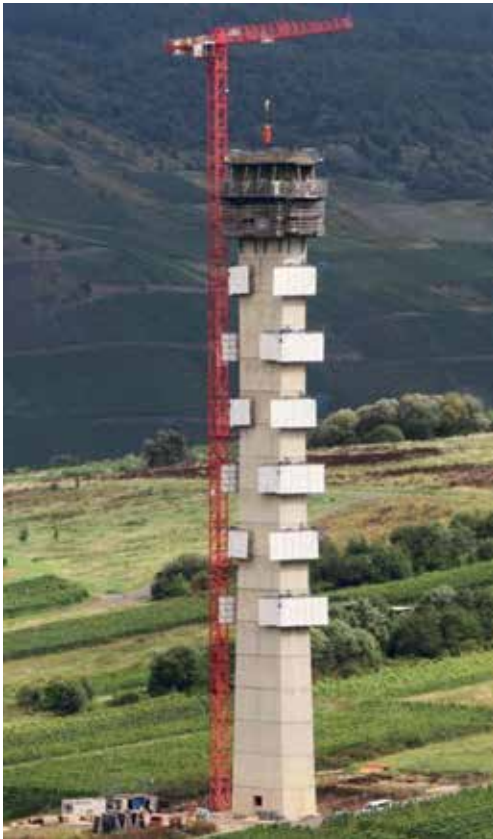
7 8 Gerüstkuben an Pfeilern und Windabweiser am Überbau © Landesbetrieb Mobilität Rheinland-Pfalz
