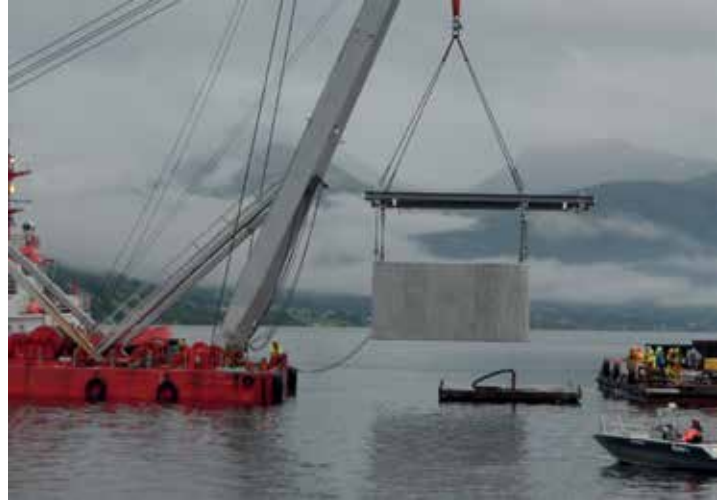
12 Einheben der Betonfertigteilkästen mittels Schwimmkran © Bilfinger Tresfjordbrücke
