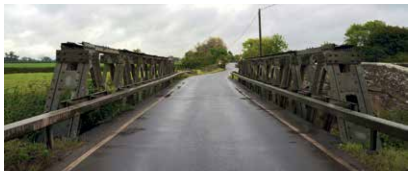
5 Feuerverzinkte Lydlinch-Brücke von 1942 © Institut Feuerverzinken
