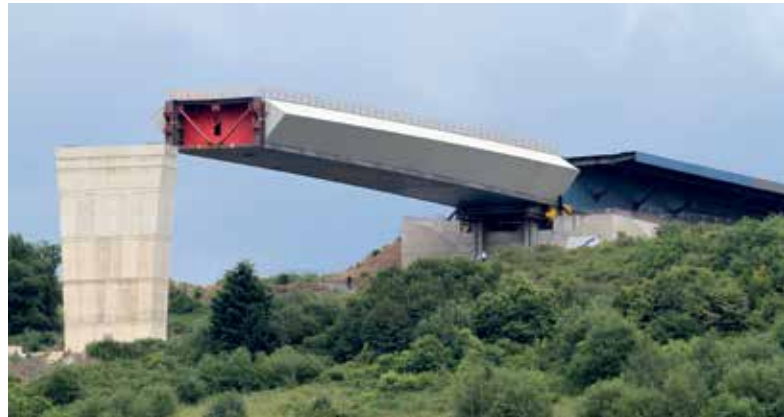
7 8 Gerüstkuben an Pfeilern und Windabweiser am Überbau © Landesbetrieb Mobilität Rheinland-Pfalz
