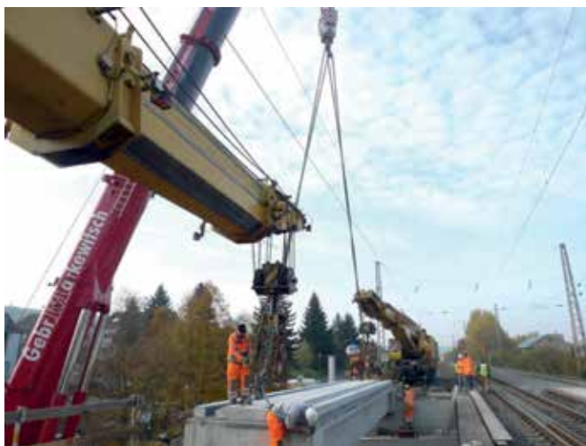
4 Einheben und Positionieren der Fertigteile © Zilch + Müller Ingenieure GmbH
