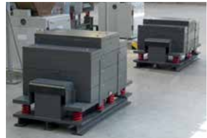
■ Tilger auf Zwischendecke © KTI Schwingungstechnik GmbH
