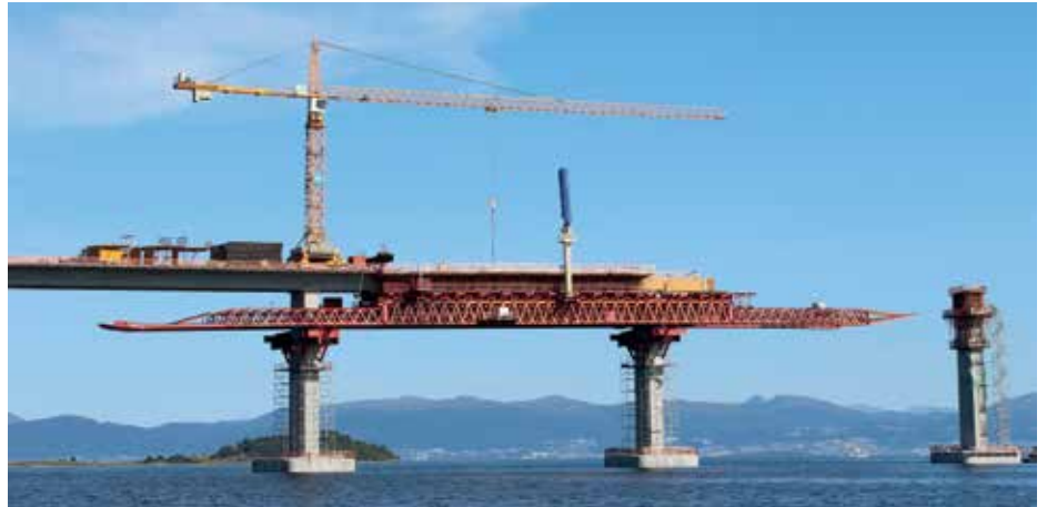
16 Vorschubrüstung mit Betonverteilermast und nachlaufendem Turmdrehkran © Bilfinger Tresfordbridge
