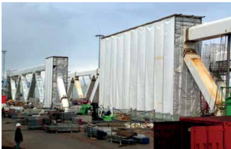
Hubteile des Brückenbauwerks vor Fertigstellung © Oerlikon Schweißtechnik GmbH
