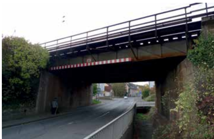
1 Bestandsbauwerk vor der Sanierung © Zilch + Müller Ingenieure GmbH
