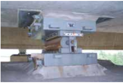
11 12 Umbau eines Rollenlagers mit Kalottenlager © Maurer AG
