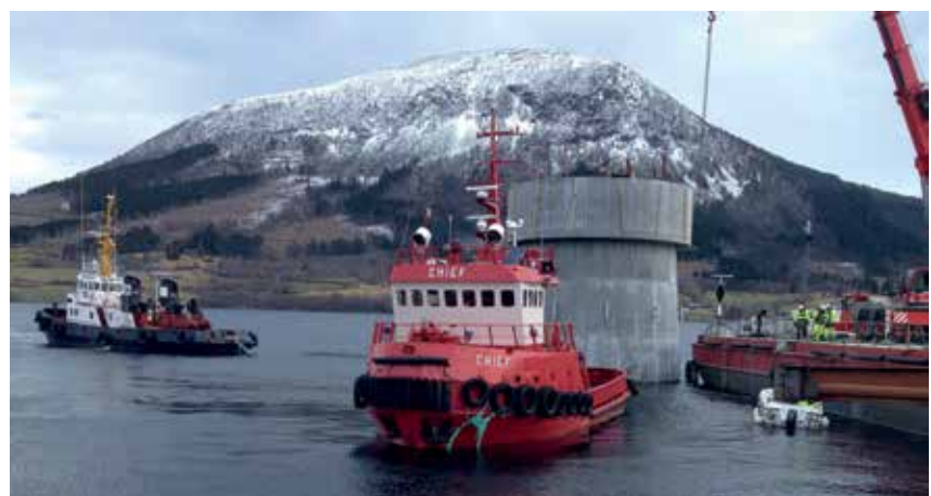
14 Endgültige Platzierung des Caissons in Achse 8 © Bilfinger Tresfordbridge
