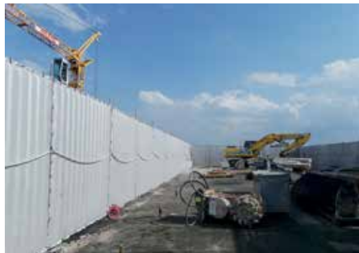
Beginn der Abbrucharbeiten © Calenberg Ingenieure GmbH
