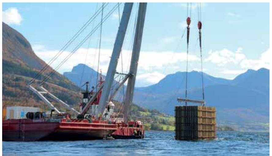
8 Einheben der Fundamentschalung inklusive Bewehrung mittels Schwimmkran © Bilfinger Tresfjordbridge
