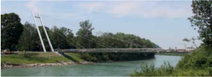
■ Wilhelm-Kaufmann-Steg kurz vor Fertigstellung © KTI Schwingungstechnik GmbH
