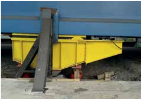
11 Verschublager mit Verschubwippe © Landesbetrieb Mobilität Rheinland-Pfalz
