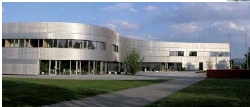
Neubau Ganztagesbetreuungsgebäude Schulzentrum Haßfurt
