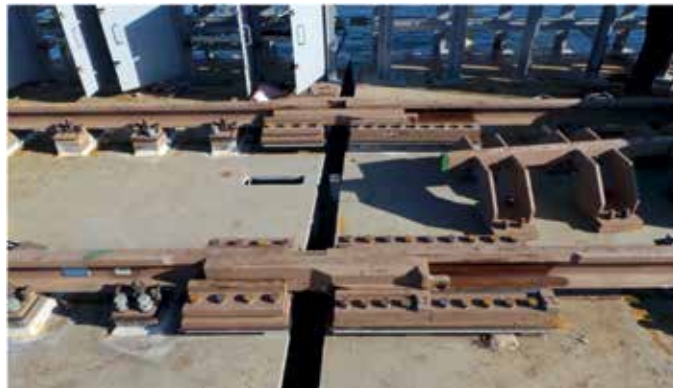
14 15 Schienenverriegelung in Planung und Bau © Waagner Biro Bridge Systems AG
