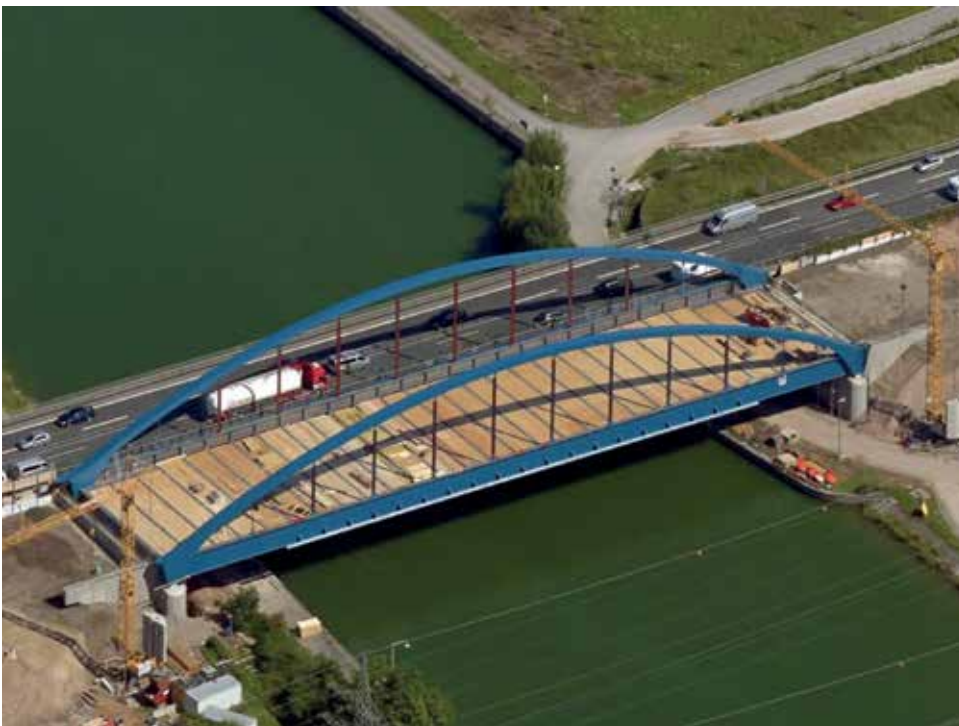
14 Neues Brückenbauwerk nach Teilfertigstellung © Autobahndirektion Nordbayern
