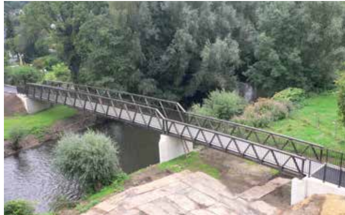
Fachwerktrögkonstruktion mit Gehbelag aus Aluminiumplattformen © Technische Betriebe Solingen
