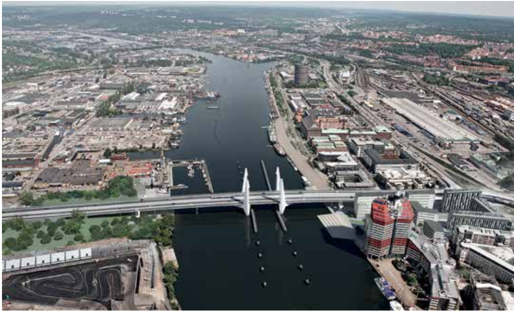
3 Neue Brücke »Hirsingsbron« im Stadtbild © Dissing + Weitling architecture a/s
