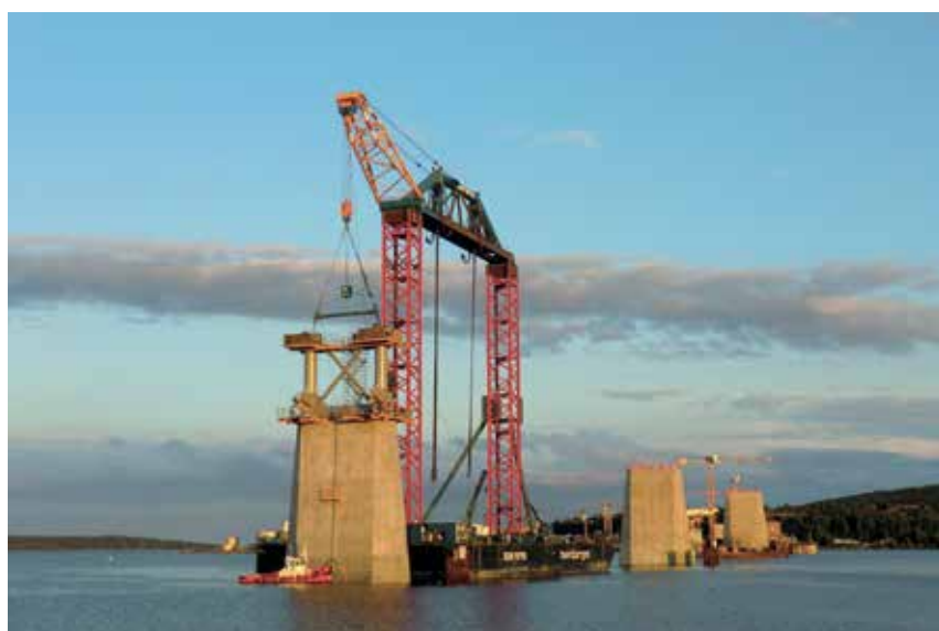
11 Einhub der vorgefertigten Pfeilerscheibe © Firmengruppe Max Bögl
