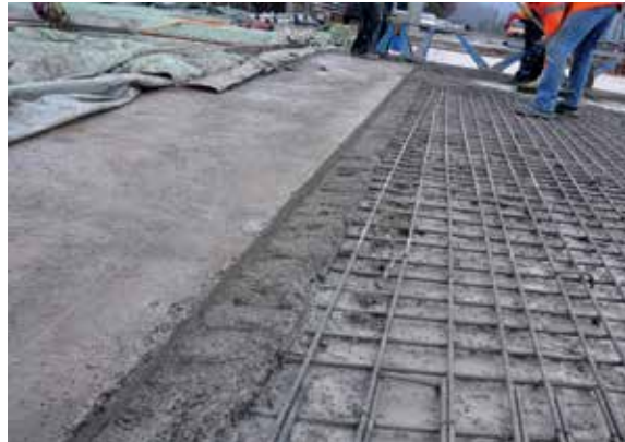
11 Ausbildung der Arbeitsfuge © Philipp Hadl/Technische Universität Graz
