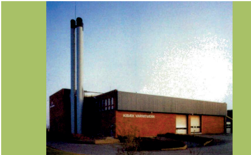
Dánská kotelna na dřevní štěpku
