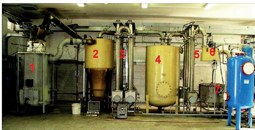
1 - zplyňovací generátor, 2 - hrubý odlučovač prachových částic (horký cyklon) 3 - první chladič plynu, 4 - vodní pračka plynu, 5 - druhý chladič plynu, 6 - odlučovač kapek, 7 - jemný filtr na odstraňování prachových částic z prací vody
