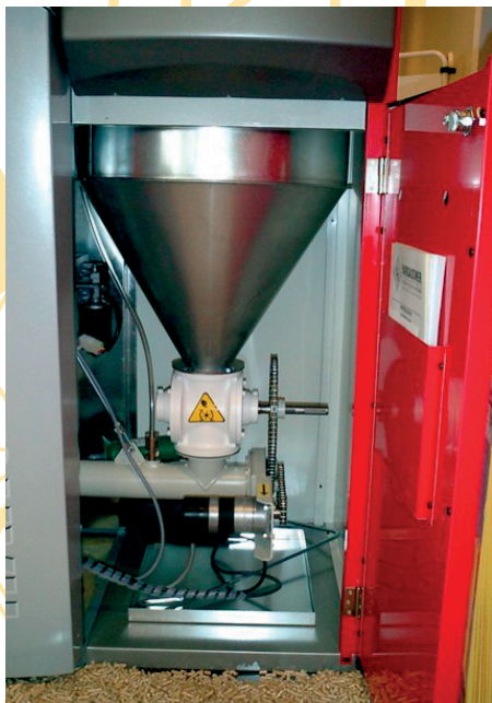
Pohled do podávací části kotle na pelety
