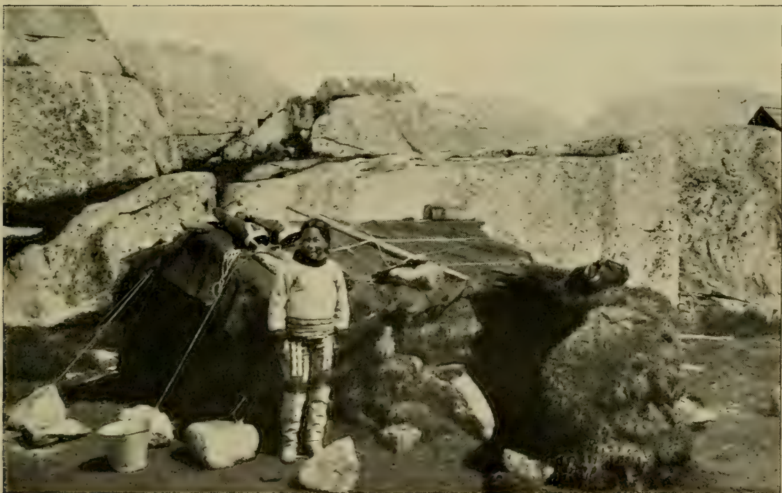
Fig. 6. Fangstthytte af Tørv og Sten med et gammelt Konebaadsskind som Tag. Sagdlit Øerne. O. Bendixen fot. d. 22/7 1919.
