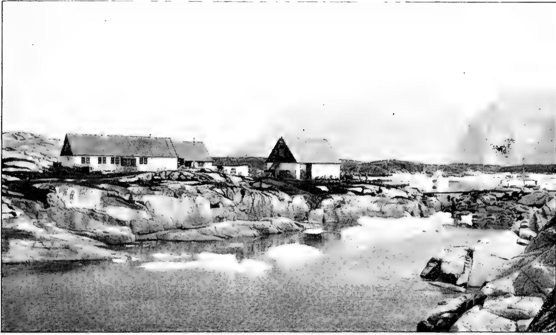
Fig. 21. Udstedet Sagdlit med Sermersôk i Baggrunden. O. Bendixen fot. d. 22/7 1919.
