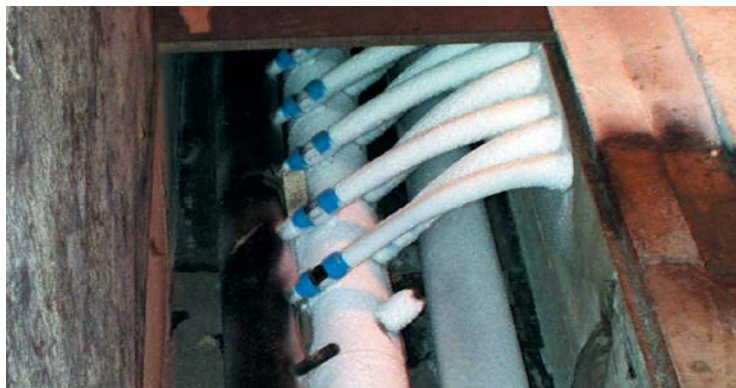
Conexión de tuberías de plástico de la pista con la distribución y colector (aislamiento térmico).
