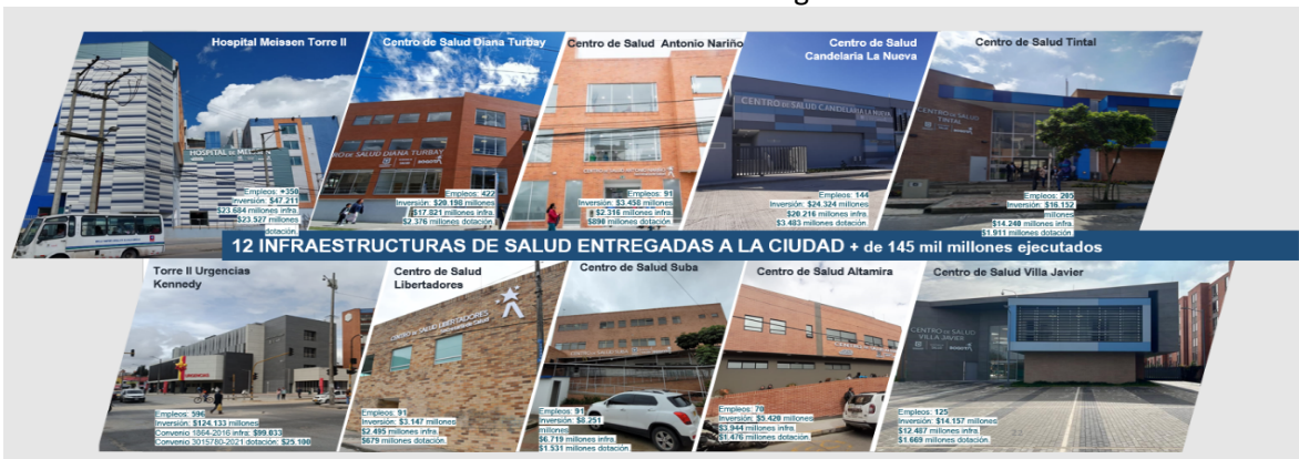
Fuente: Dirección de Infraestructura y Tecnología. (2023). Infraestructuras entregadas en 2023. [jpg]. Repositorio de Información Dirección de Infraestructura y Tecnología https://saludcapitalgovco.sharepoint.com/sites/AnalisisdeDatosSDS/subplaneacion/SitePages/Repositorio-DIT.aspx
