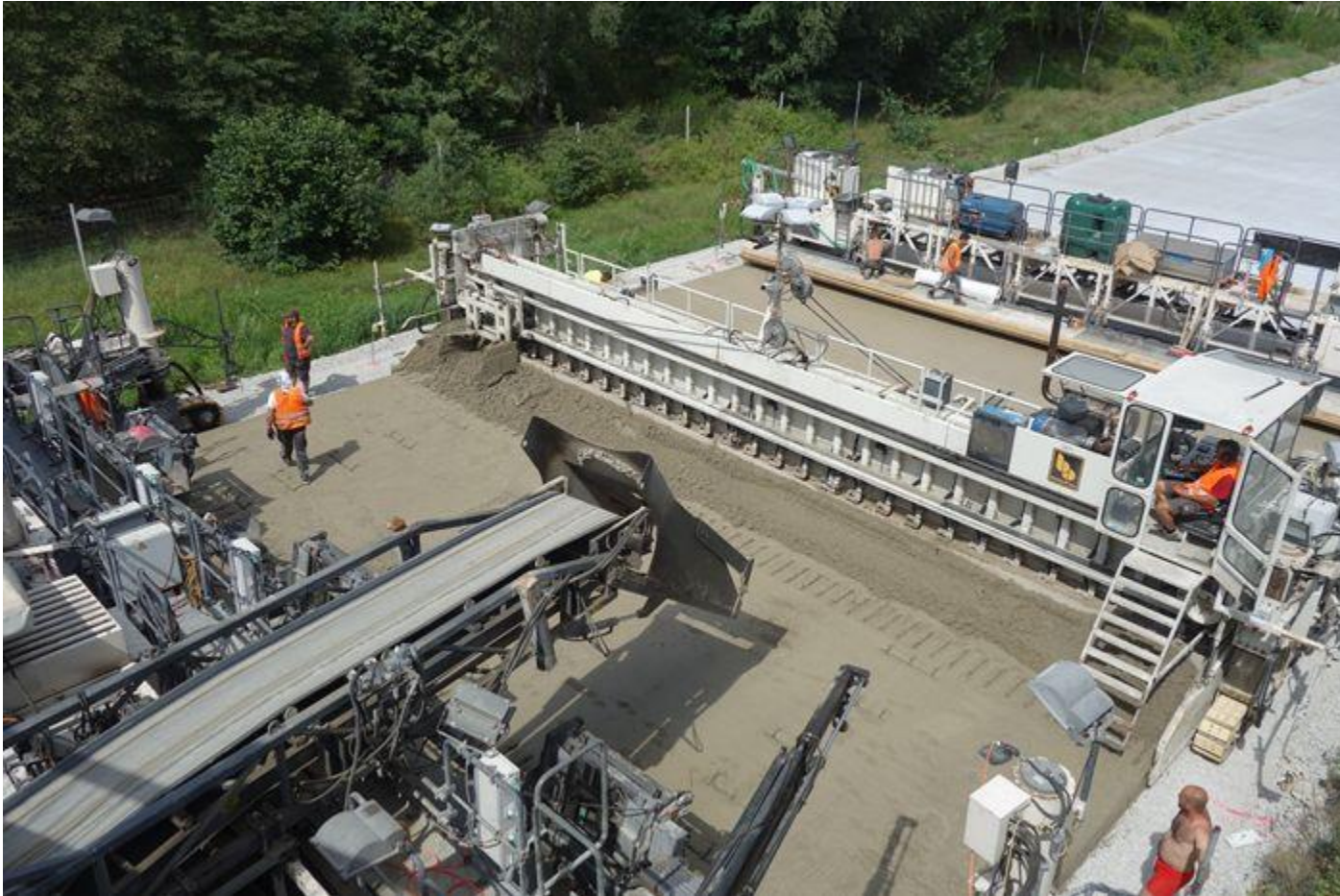
Maschineller Einbau mit Gleitschaltungsfertiger
