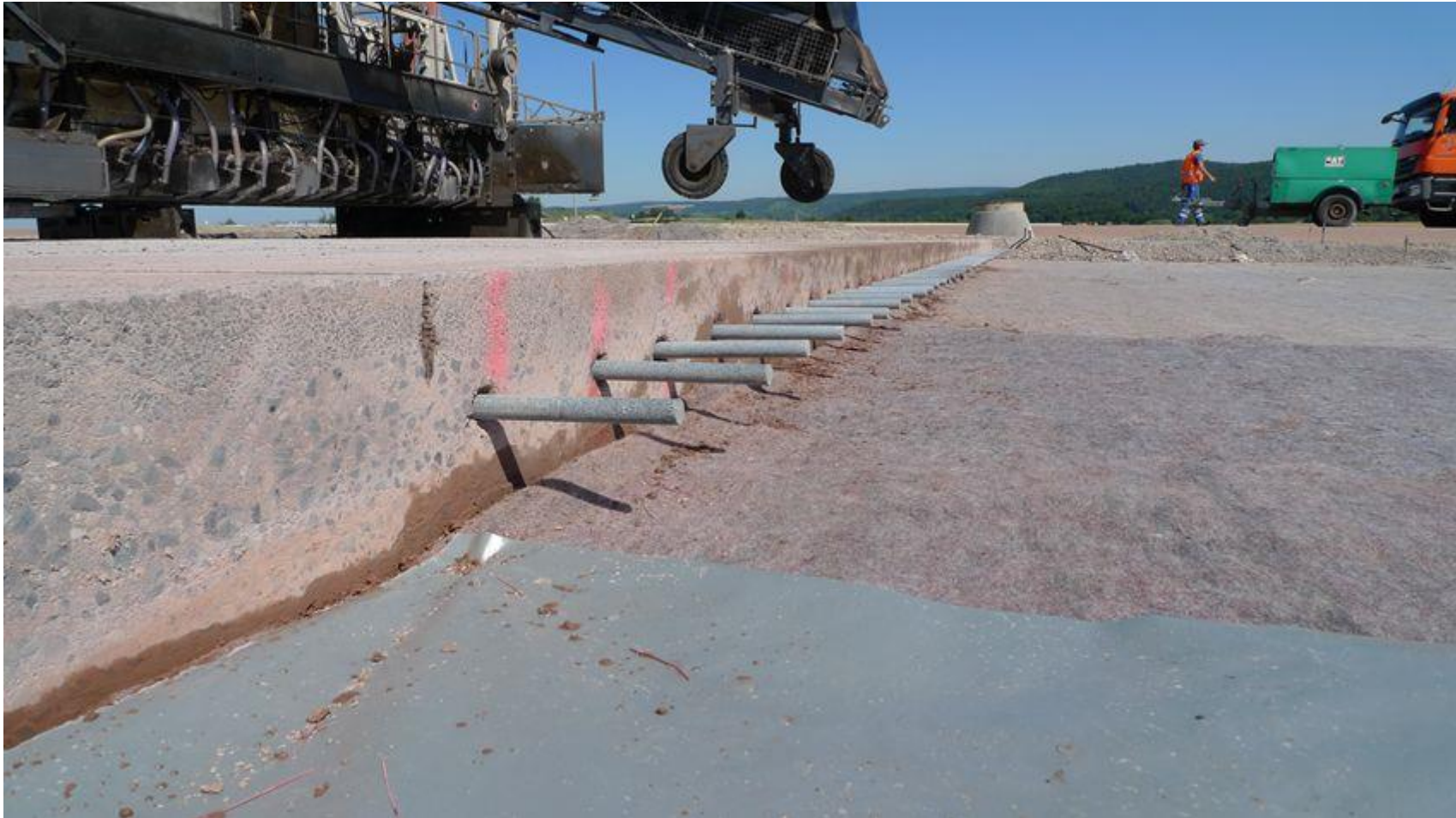
Dübel an einem Tagesansatz
