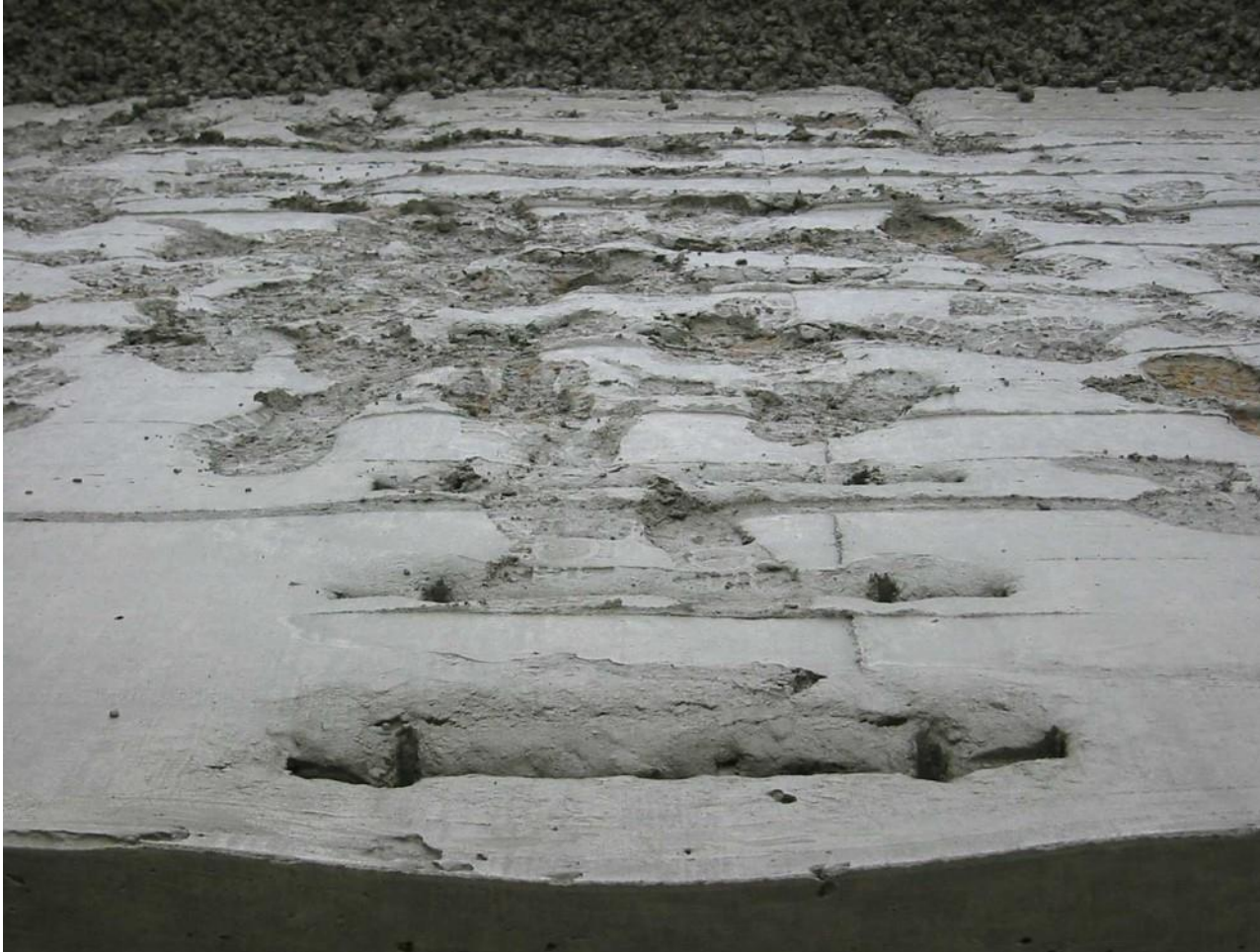
Dübel und Anker im Frischbeton gesetzt
