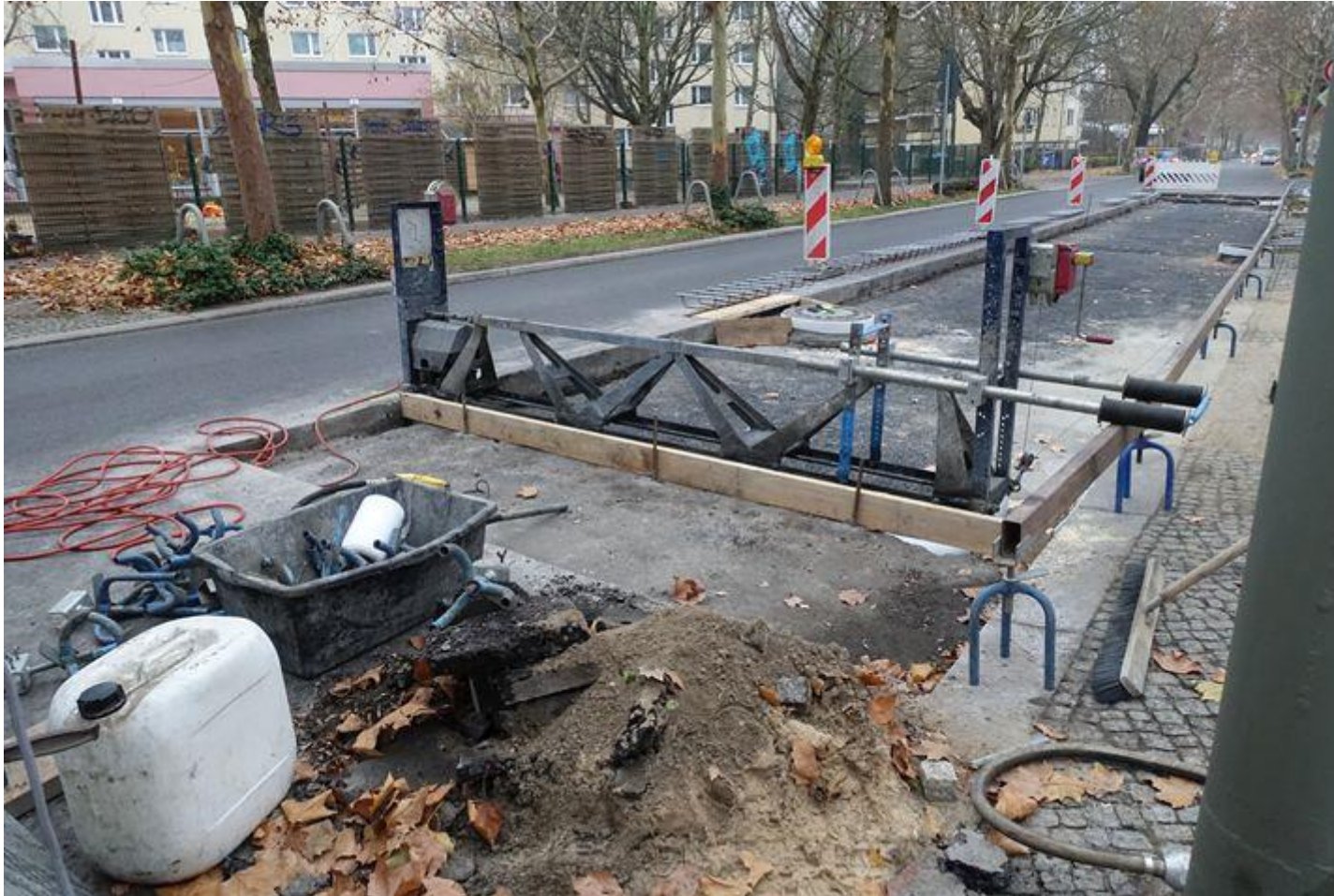
Handeinbau mit Rüttelbohle
