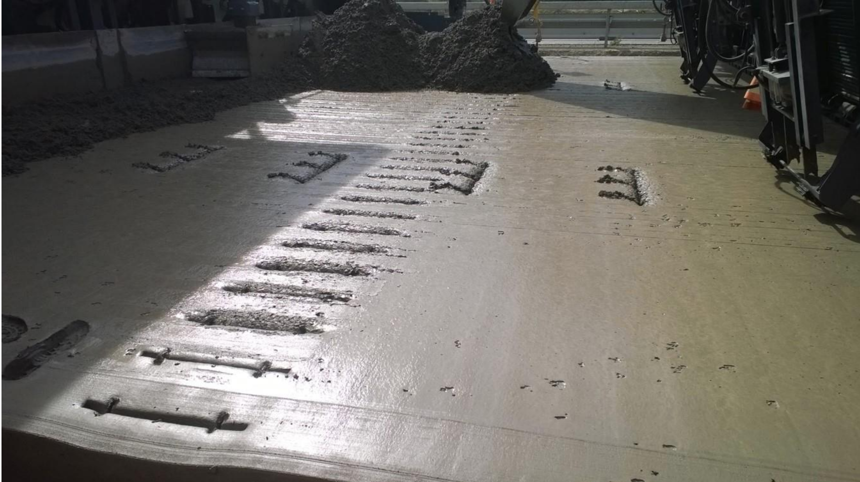
Dübel und Anker im Frischbeton gesetzt
