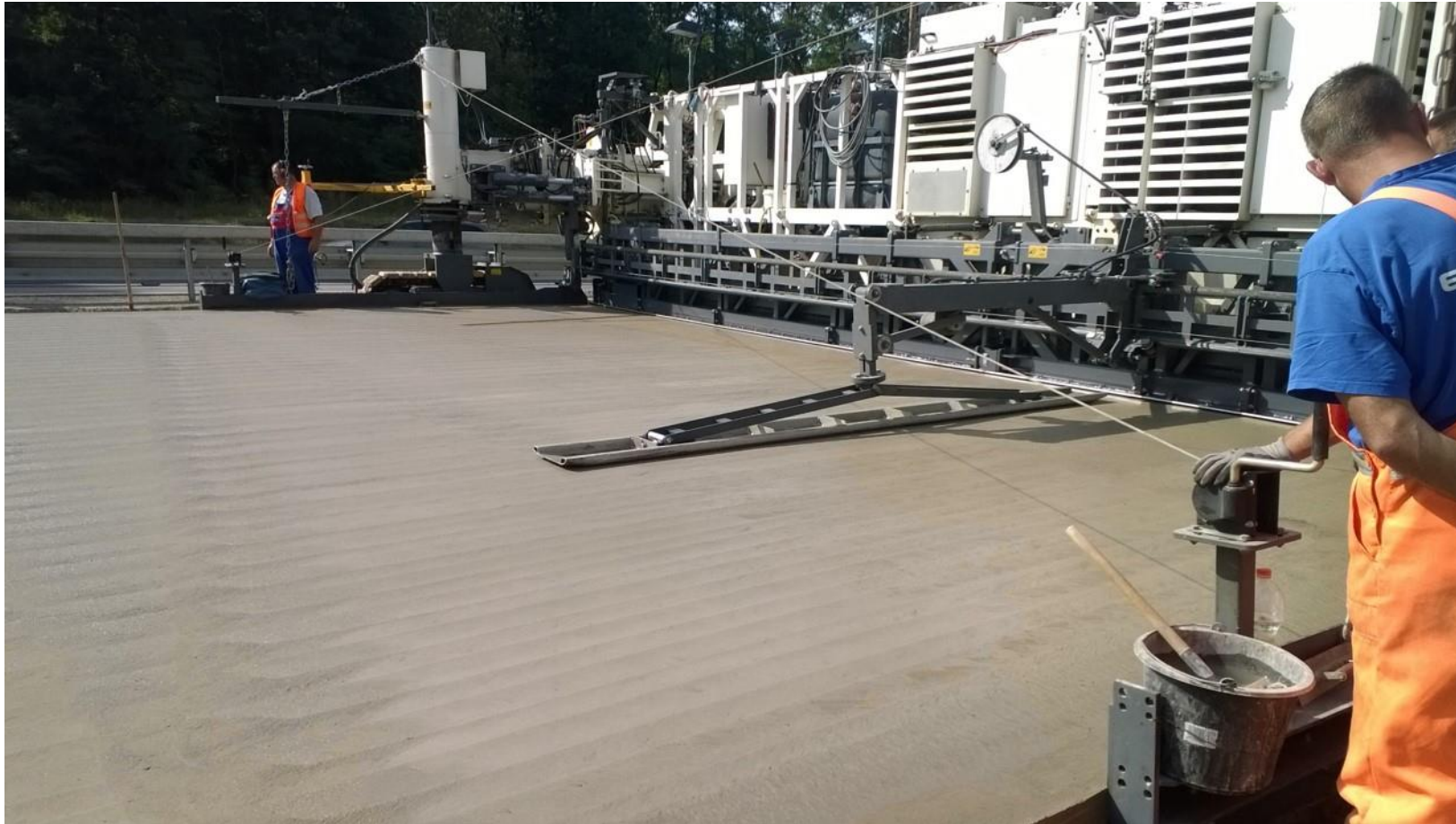
Maschinelles Einbau mit Gleitschaltungsfertiger
