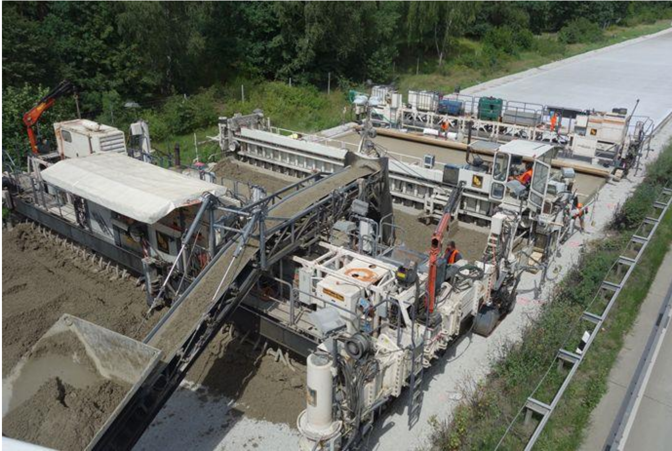
Maschinelles Einbau mit Gleitschaltungsfertiger
