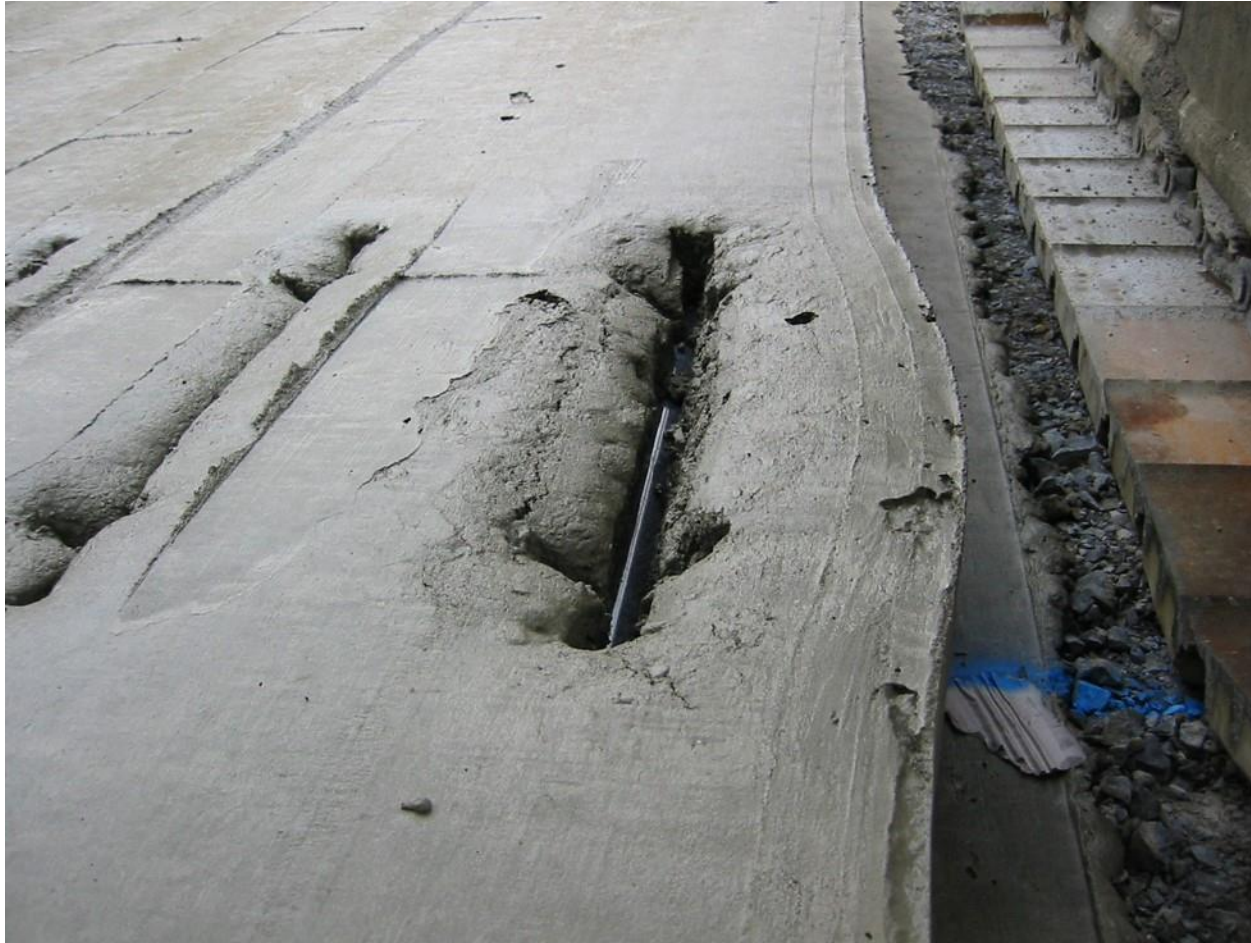
Dübel und Anker im Frischbeton gesetzt
