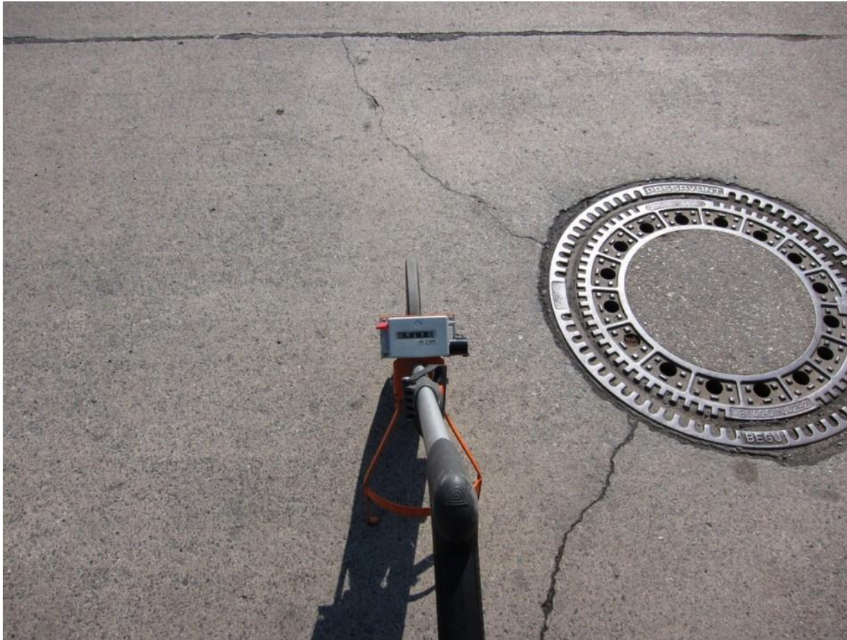
Betonstraße in Berlin, 2018
