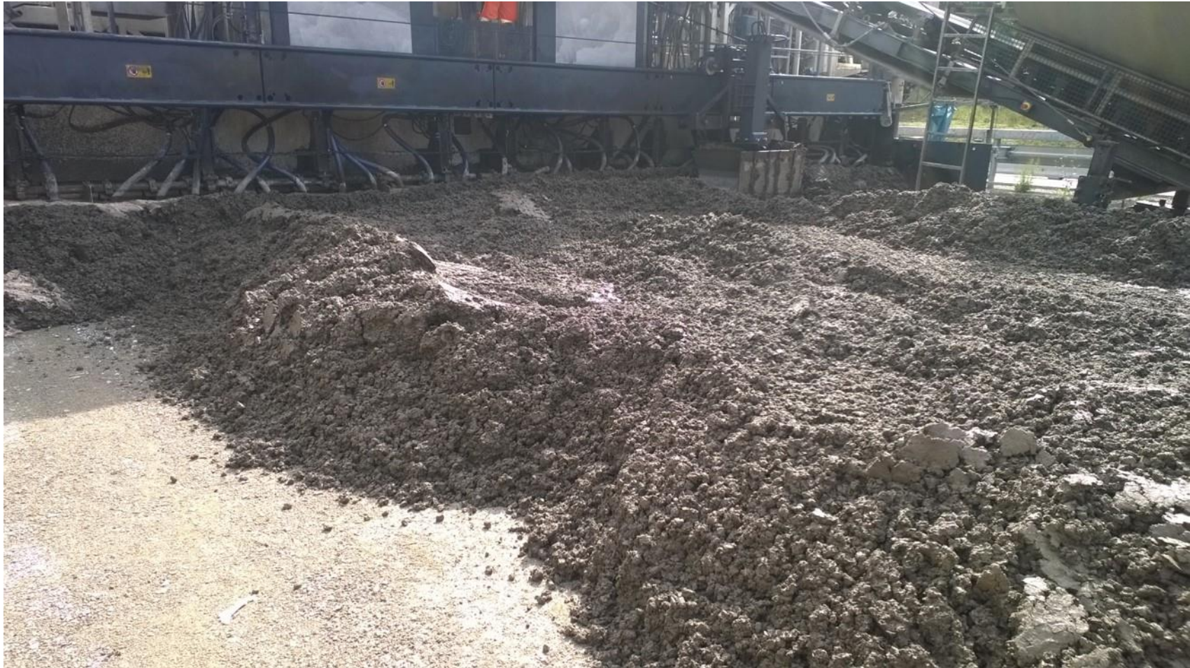
Maschinelles Einbau mit Gleitschaltungsfertiger
