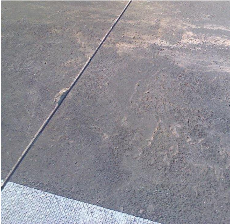
Mörtelanreicherungen Waschbeton
