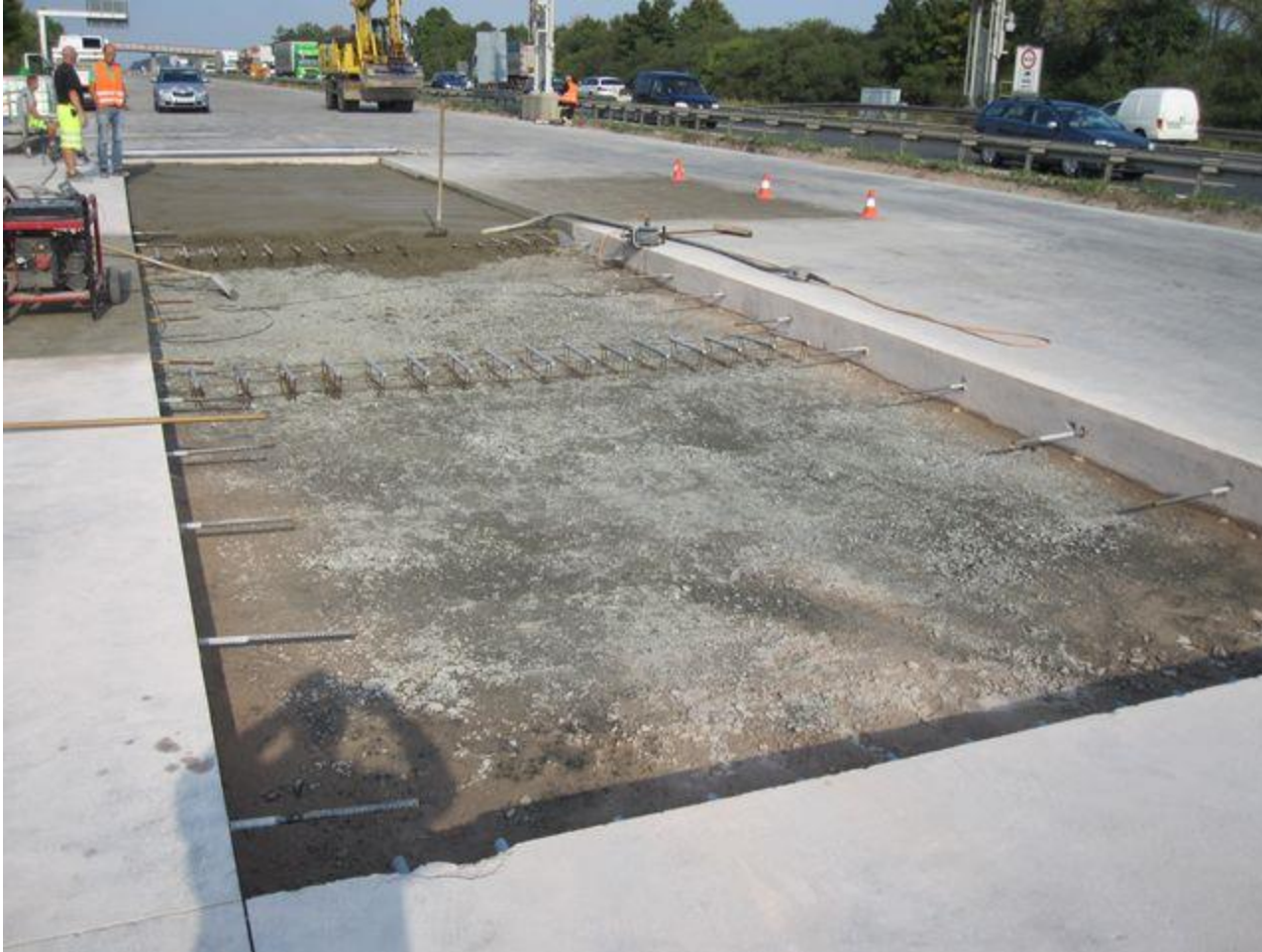
Dübel auf Körben und Klebeanker
