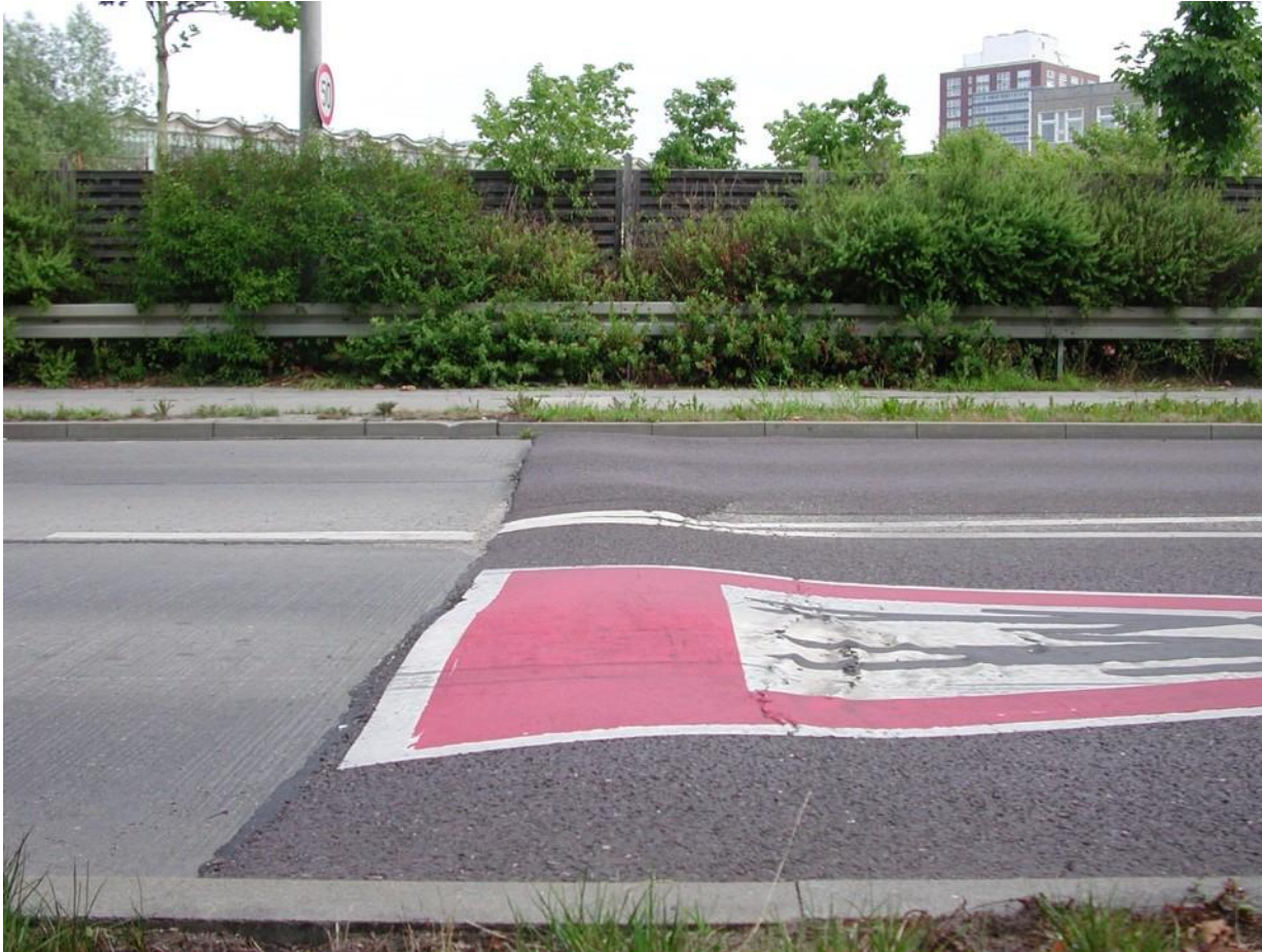
Anordnung von Raumfugen oder Asphaltvorfeldern
