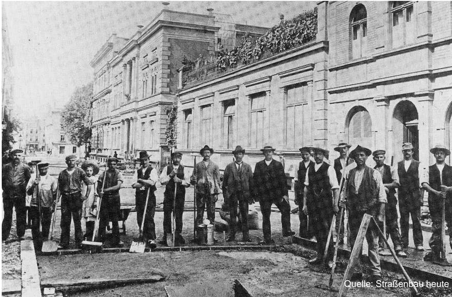
Bau der Poststraße in Bunzlau/Niederschlesien, 1906
