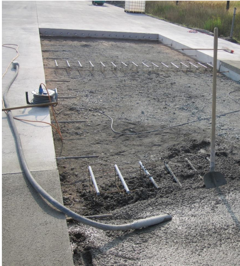
Handeinbau mit Rüttelflasche und Glättwalze
