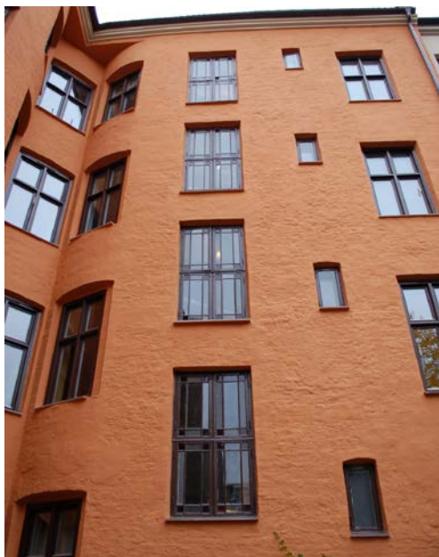
I denne typiske murgården har man restaurert de gamle trapperomsvinduene, mens leilighetsvinduene er byttet ut.
