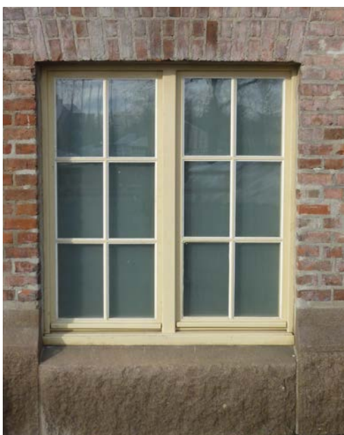
Eksempel på nytt, koblet vindu med blant annet gjennomgående sprosser, samme rammeinndeling som det opprinnelige vinduet, og riktig plassering i vegglivet.
