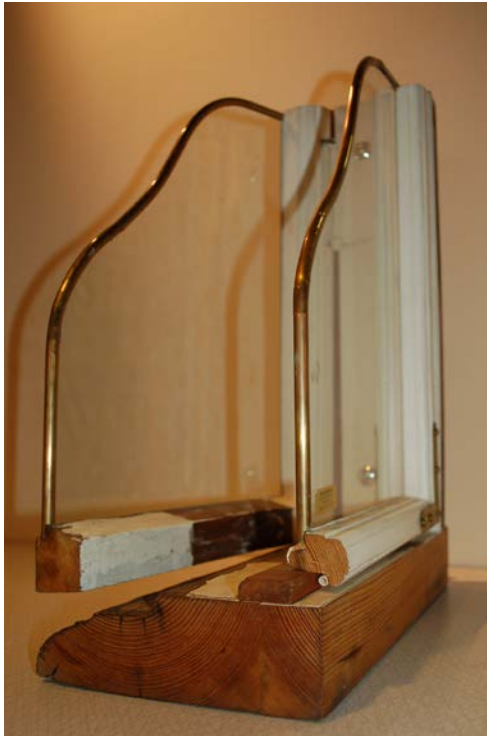
Vindusmodell som viser hvordan et 100 år gammelt og dårlig vedlikeholdt vindu har friskt treverk selv om overflaten er slitt. Vinduet er oppgradert med tetningslist og energiglass i varevinduet.
