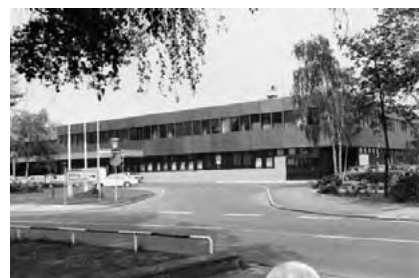
1977/78 Fertigstellung und Bezug des neuen Südostflügels
