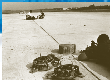
Montage der Mittellinienbefeuerung auf der Startbahn
