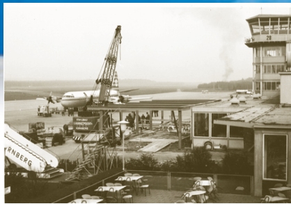
Fluggastraum-Erweiterung im Bau
