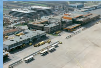
1988/89, 1. Parkhaus im Bau
