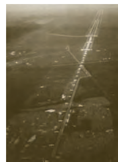
Die Firma Siemens installiert auf der Landebahn eine Mittellinien- und Aufsetzonen-Befeuerung
