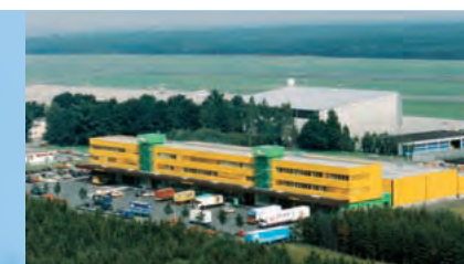
Fertigstellung des neuen Cargo Centers Nürnberg (CCN)
