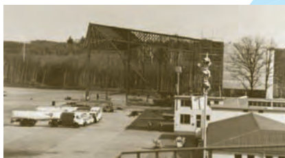
Die neue Halle für Verkehrsflugzeuge im Rohbau
