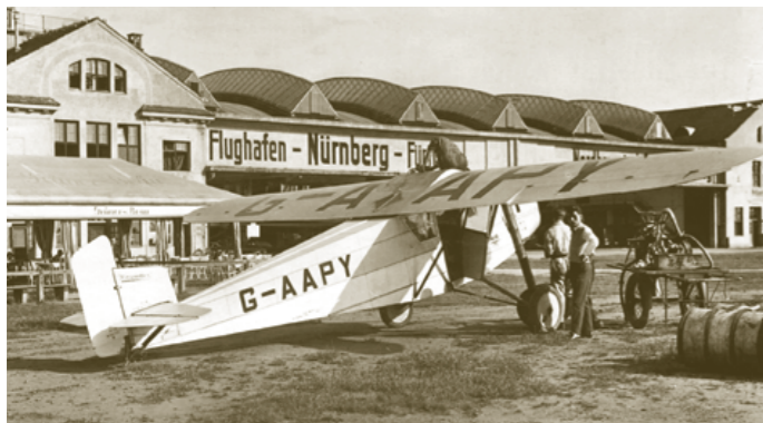
Werftgebäude Flughafen Atzenhof, um 1929
