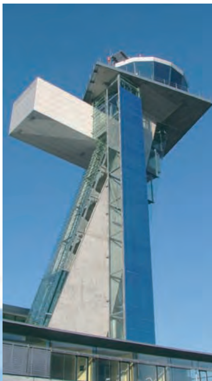
Der neue Tower
