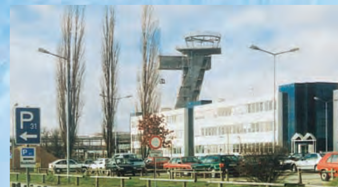
Richtfest neuer Tower
