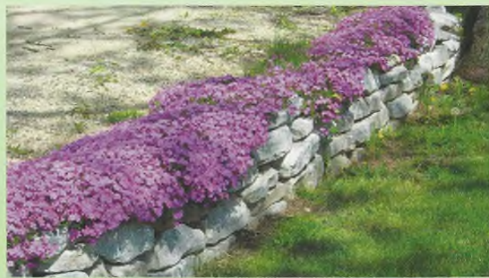
Каміні вкладають один на один без використання розчину, а щілини між ними заповнені землею куди і висаджені рослини
