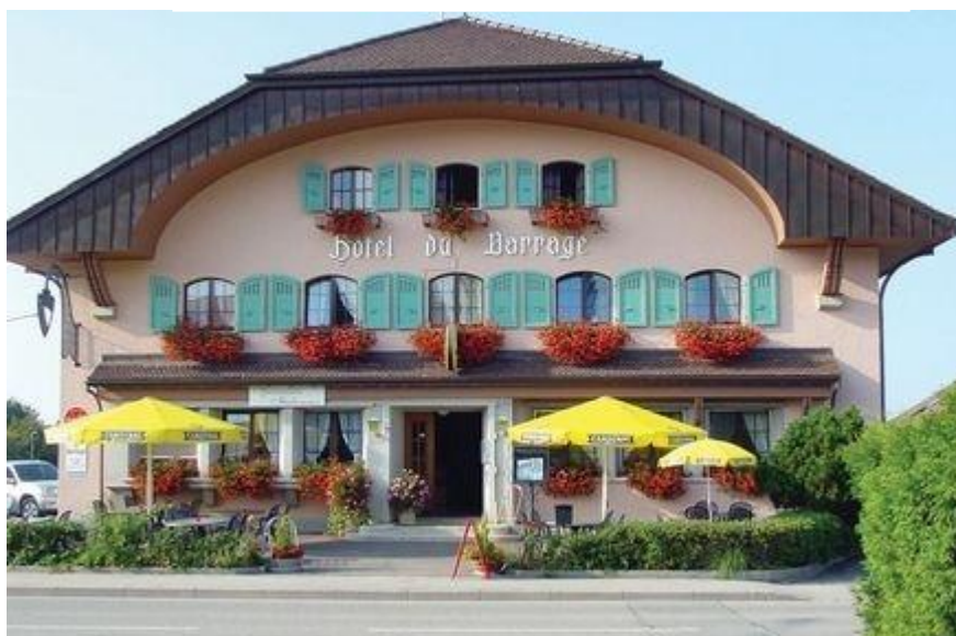
Fig. 18 : Hôtel du Barrage de Rossens
