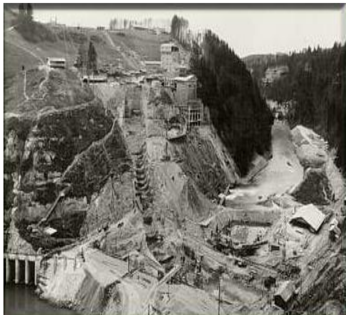
Fig. 10 : La construction du barrage
