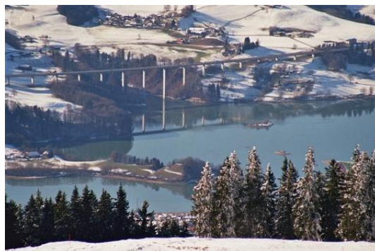
Fig. 28 : Le viaduc de la Gruyère de l'autoroute A12
