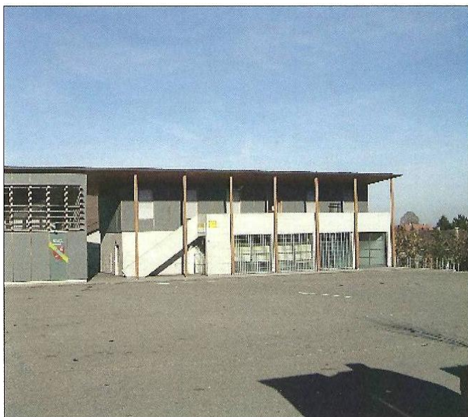
Fig. 22 : Le bâtiment abritant l'administration communale et la nouvelle poste
