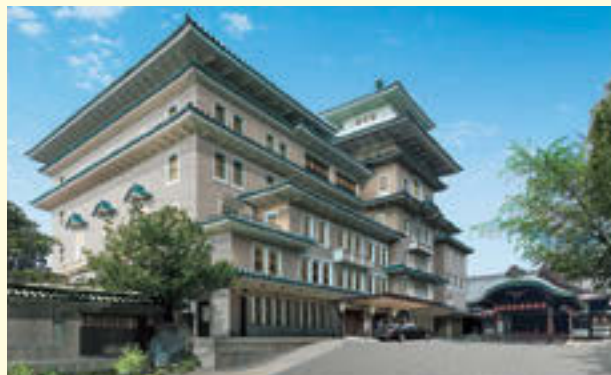
京都における新規ホテル(本棟)の外観イメージ
