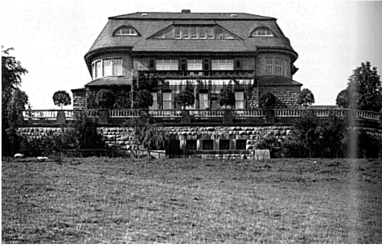
86 Osthaus' Wohnhaus 'Hohenhof' in Hagen, 1906/08
