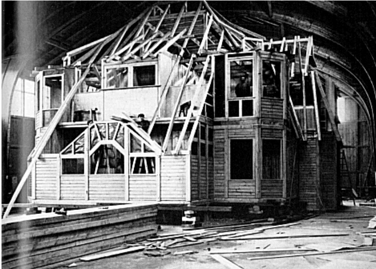
117 Präfabrikation des Hauses 'De Tent' in der Fabrik
