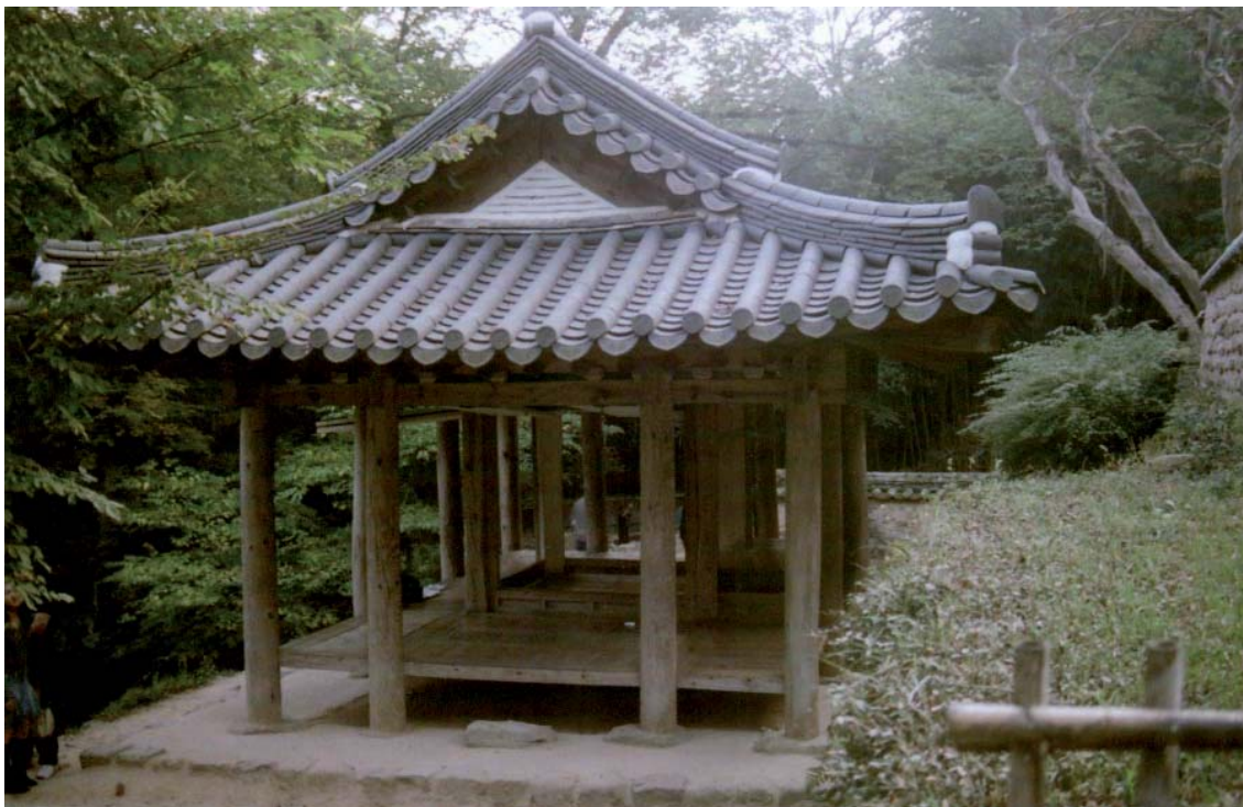
Abb.1, Soswaewon, Blick auf den Kwangpunggak von Norden, Aufnahme ca. 2006
