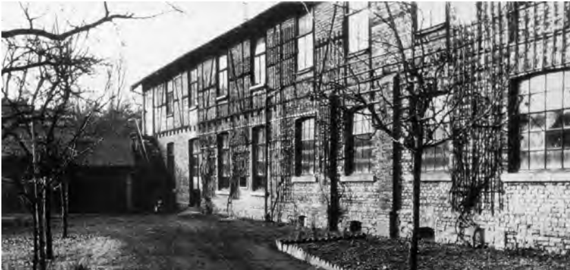
Das ehemalige Sarglager in Oberursel
