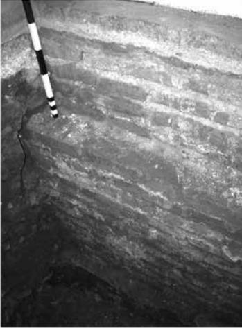
**Figura 13.** Cimiento escalonado del muro. Foto: M. Saavedra.
