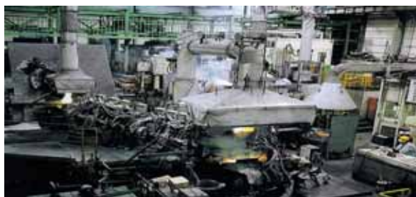
縦型連続鋳造炉
