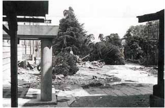
昭和25年のジェーン台風による被害：本局旧正門付近
