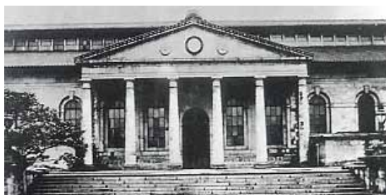
改築前の表工場正面
