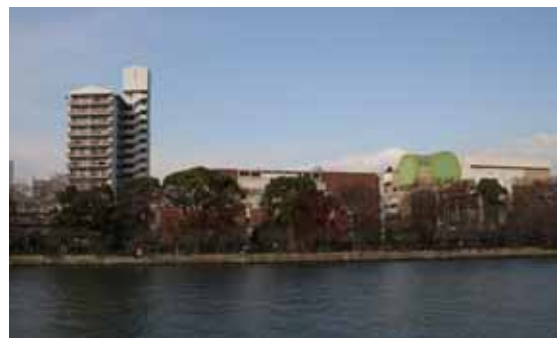
本局の高層化された南宿舎(平成19年)
