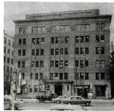
東京出張所が開設された幸ビル
