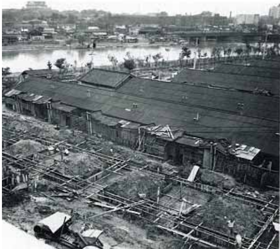
本局木造宿舎の取り壊し(昭和28年)
